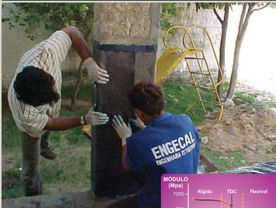
A integração fibra de alta resistência/adeseivo epóxico é a melhor demonstração da eficiência dos polímeros aglomerantes epóxicos.
