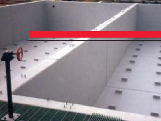
O fundo de tanques de concreto ou qualquer reservatório é propício à surgência de umidade proveniente do solo.
