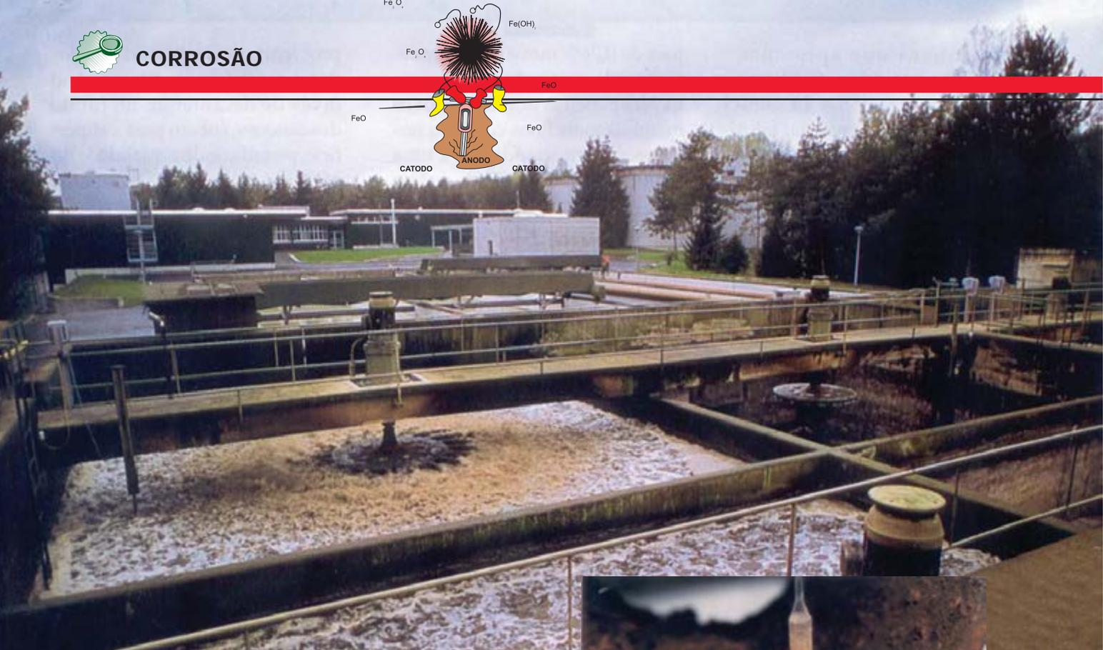
Nas estações de tratamento de esgotos estão as maiores ocorrências da biocorrosão, tanto no concreto armado como nas tubulações.
