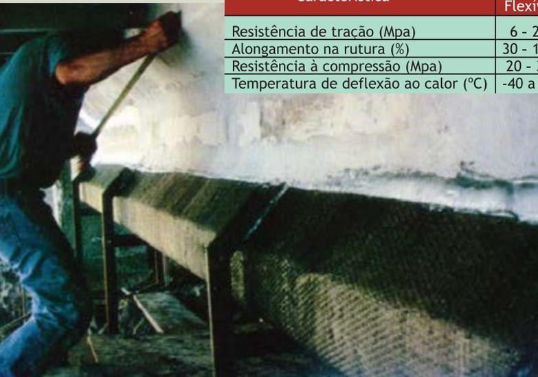
O reforço estrutural com PAF (fibra de carbono) em uma viga I pré-moldada que estará submetida a cargas adicionais.
