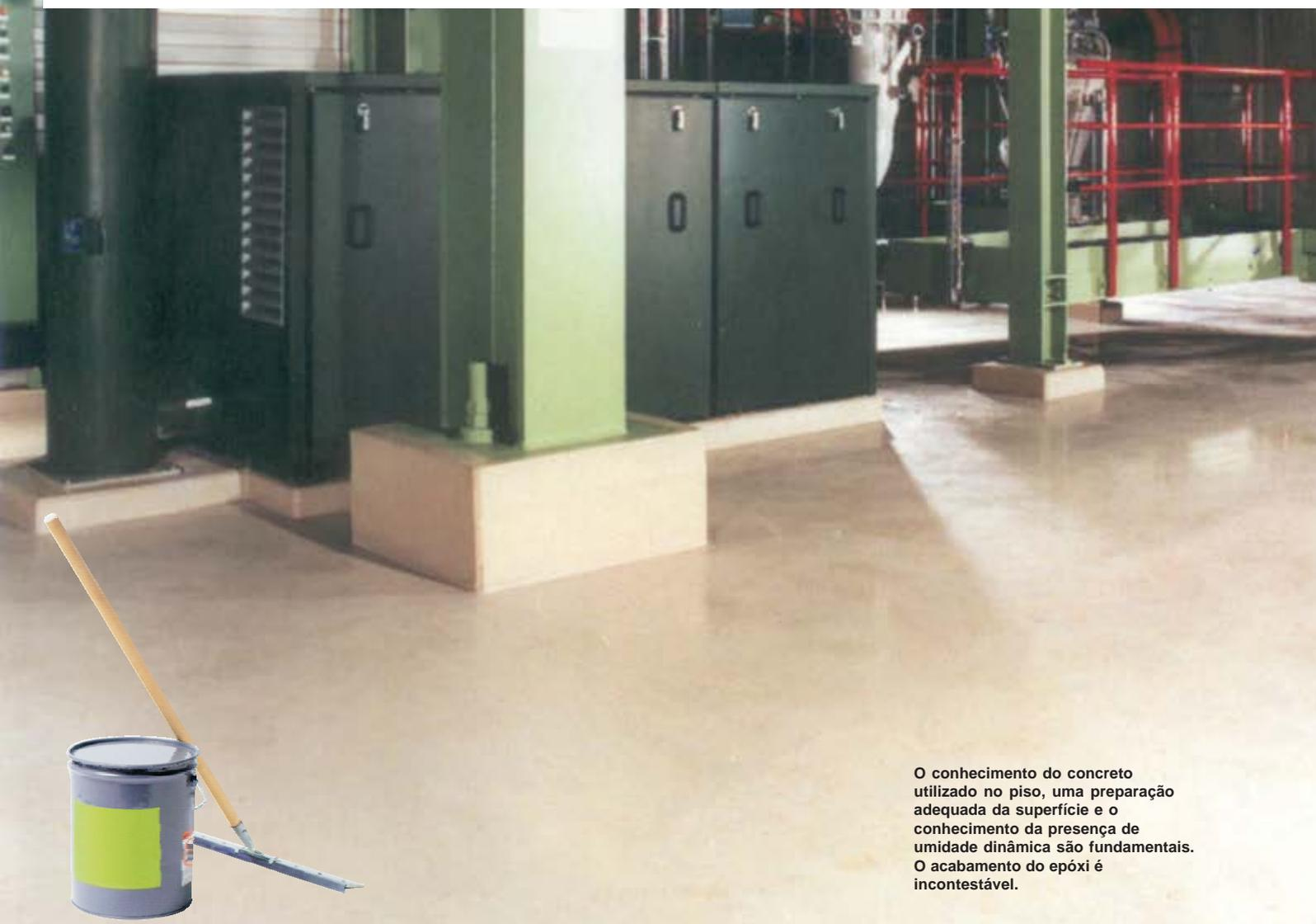
O conhecimento do concreto utilizado no piso, uma preparação adequada da superfície e o conhecimento da presença de umidade dinâmica são fundamentais. O acabamento do epóxi é incontestável.
