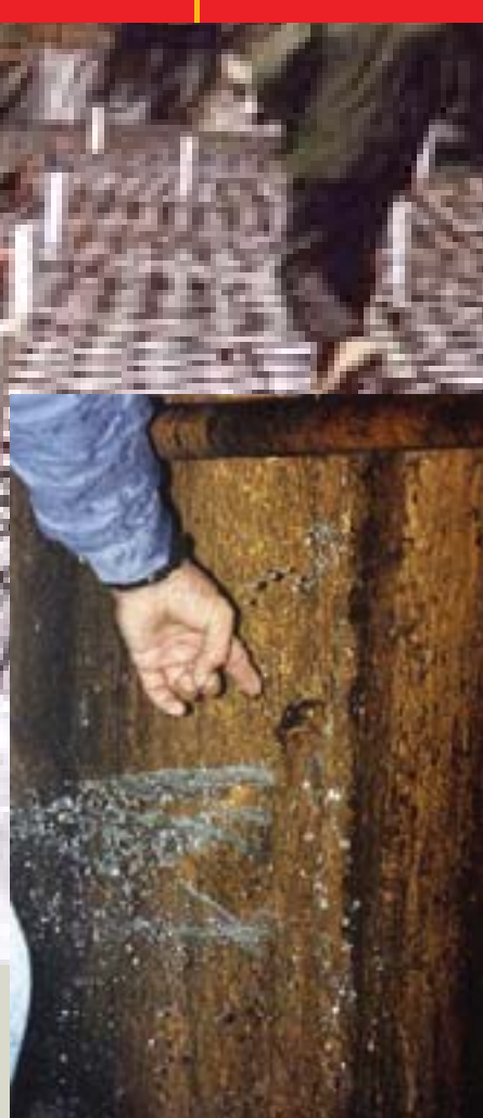
A pressão hidrostática atuando em uma parede.
