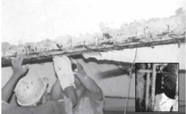
A aplicação de tintas na superfície das armaduras, efetivamente, só piora o estado da corrosão na estrutura.
