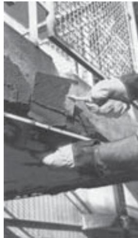
“Recuperação” com pintura inibidora de corrosão.
