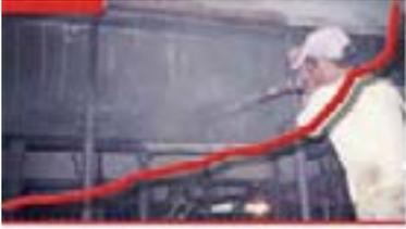
Figura 10 - Aqui também um encamisamento agora com concreto projetado. O motivo foi a corrosão nas armaduras. O projetista, desconhecendo o verdadeiro tratameto de neutralização da corrosão, mandou fazer o reforço com novas armaduras e tome uma seção maior de concreto. Em poucos anos teremos o mesmo problema, só que com uma seção maior.
