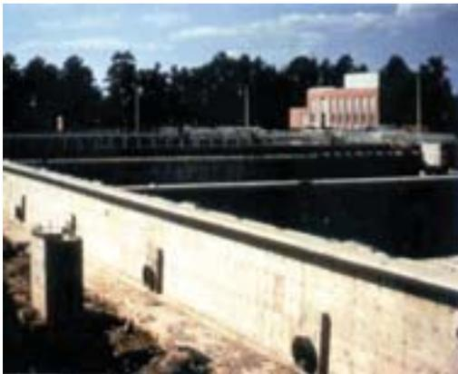
Concreto com retração compensada nesta estação de tratamento de esgotos devido a resistência aos sulfatos e ausência de trincas e fissuras por retração.
