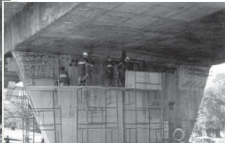
Repare nesta seqüência de fotos que um reforço estrutural está em marcha. O motivo? Corrosão na zona de fregagem do pilar, devido a ausência de impermeabilização na junta de dilatação. Tratou-se o efeito e esqueceu-se a causa. O serviço foi realizado sem o tratamento da junta. Descaso da autoridade competente? A corrosão irá alastrar-se para as novas armaduras. Novos serviços a vista.
