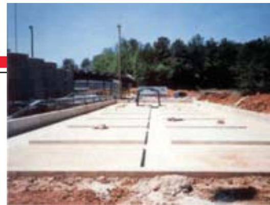
Concreto feito com cimento K. Ausência de juntas de controle neste piso de refinaria.
