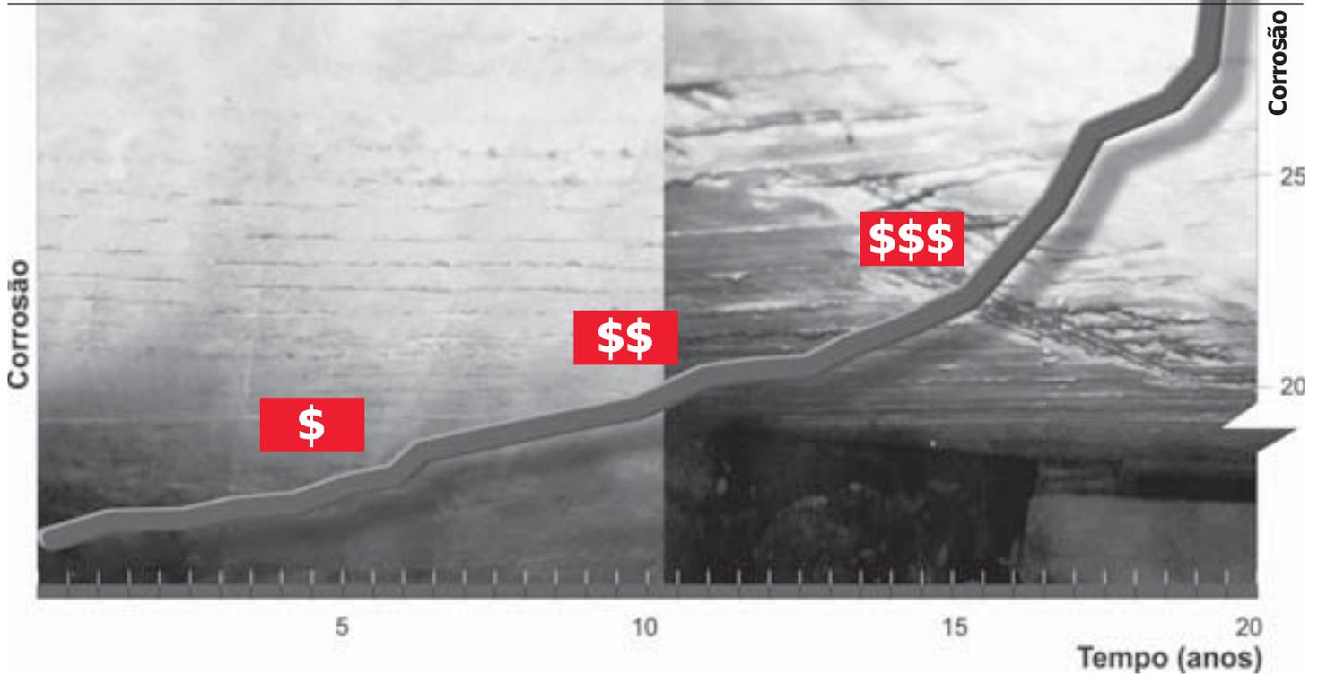
Na seqüência de fotos acima verifica-se perfeitamente o avanço do estado de corrosão das armaduras no fundo de uma laje.
