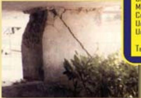
Fratura cizalhante e um grande pilar devido a mudanças no volume da estrutura. Situação perfeitamente prevista.
