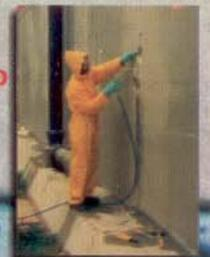
A tecnologia da injeção com poliuretano hidroativado PH Flex ataca, de maneira profunda, a água de onde quer que ela venha. Assim, infiltrações em galerias e paredes de barragens, paredes diafragma, minações d'água em pisos e poços de elevadores, metrô e vazamentos em castelos d'água são resolvidos direta e profundamente, sem chance de retorno. Para sempre!
