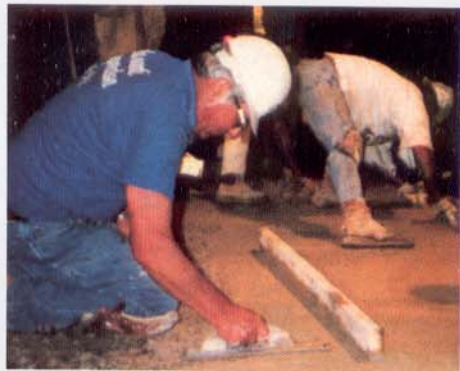
O acabamento no overlay só deve ser feito após o término do processo de exudação da massa.
