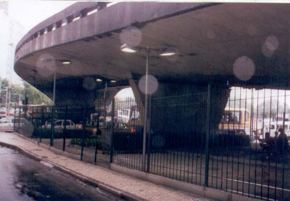
Este viaduto, com apenas uma viga-caixão, apresenta sintomas de corrosão na lage inferior.
