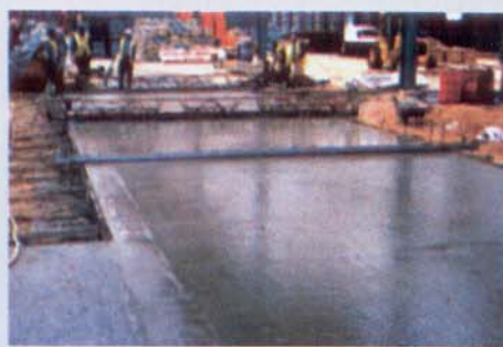
Figura 3 - Acerto do nivelamento.
