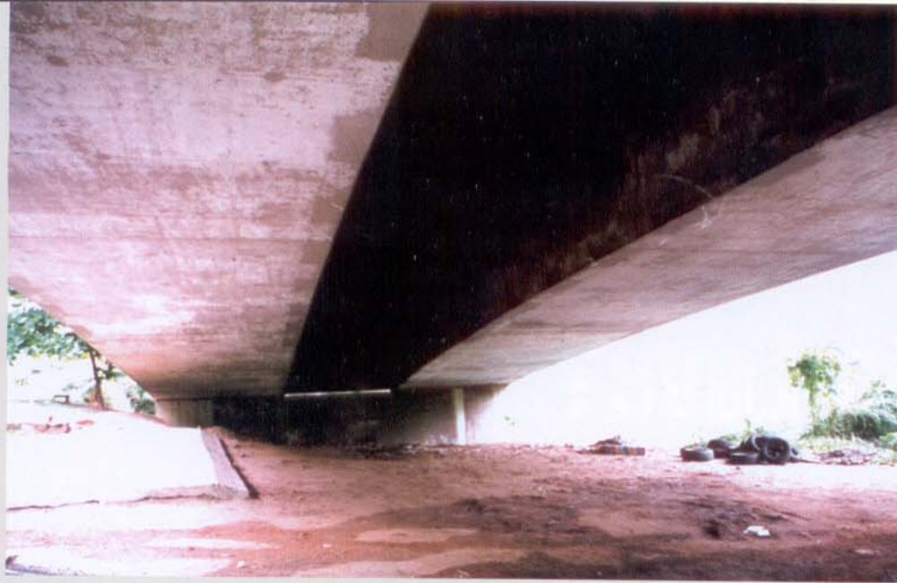
Figura 3 - Ponte com viga-caixão em dupla seção.
