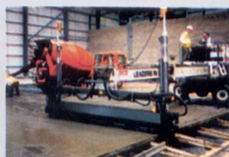
Figura 4 - Compactação e nivelamento final.
