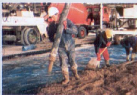
Figura 2 - Início da concretagem do piso.
