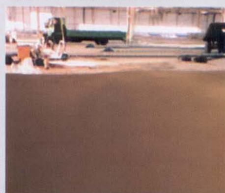
Figura 7 - Imprimação com EPÓXI 24 horas. O piso está pronto para receber o acabamento final.
