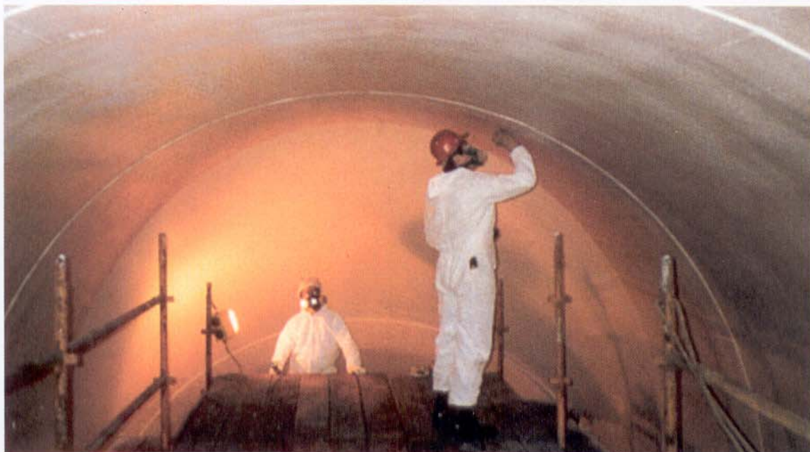
Figura 5 - A formulação mais adequada para a tinta protetora da superfície metálica/concreto é o epóxi novolac, com 100% de sólidos.
