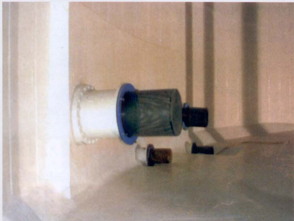
Figura 3 - O interior de um grande tanque metálico para líquidos, testado com busca-furos.
