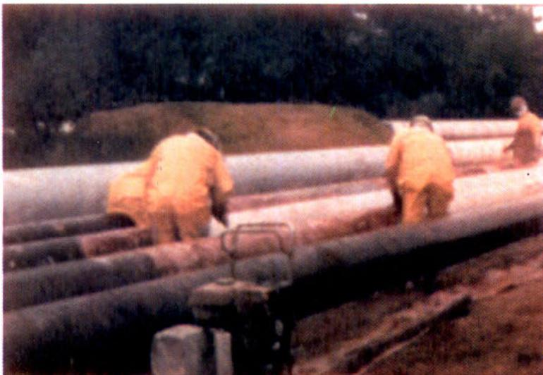
Remoção da tinta, após a aplicação do decapante em tubulações.
