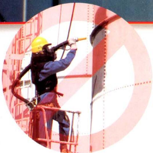
A aplicação de duas demãos de decapantes à base d'água, com o uso de espátulas, removeu totalmente a grossa película de tinta neste tanque.
