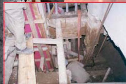
Ruína de estacas e pilares devido a corrosividade do solo.
