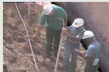
Medindo o potencial e a corrente entre o anodo de sacrifício e o fio protendido. A linha do anodo foi posteriormente coberta com material condutivo.
