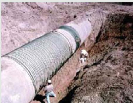
Outro trecho sendo reforçado com barras de fibra de carbono inseridas em sulcos preenchidos com epóxi.
