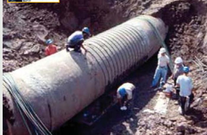
O reforço estrutural com barras de fibra de carbono, anterior à instalação dos anodos de sacrifício.
