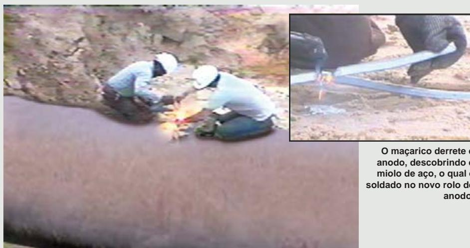
O maçarico derrete o anodo, descobrindo o miolo de aço, o qual é soldado no novo rolo de anodo.
