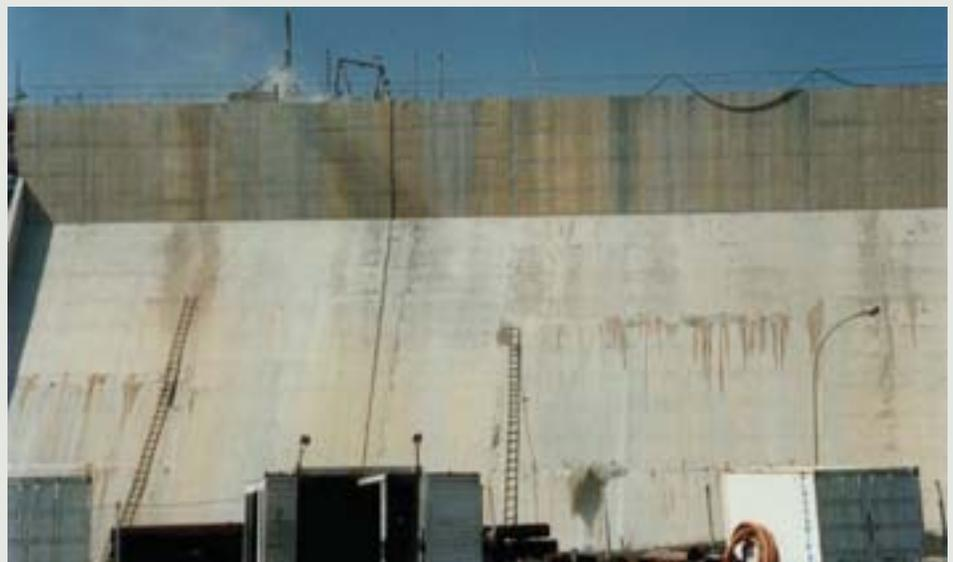
Figura 5 - Perfurações e a injeção ao longo da crista, repare a perfuratriz abrindo novos furos. Note a urgência da espuma pelo meio do paramento de jusante.
