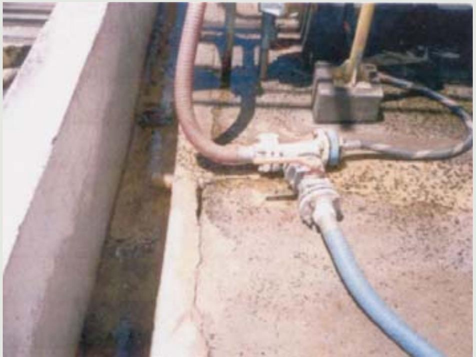
**Figura 3 - Situação típica nas indústrias: um simples piso de concreto, cheio de emendas, quase sempre não armado e uma mureta de alvenaria fazendo às vezes da bacia. Há impermeabilização contra solventes orgânicos?**
