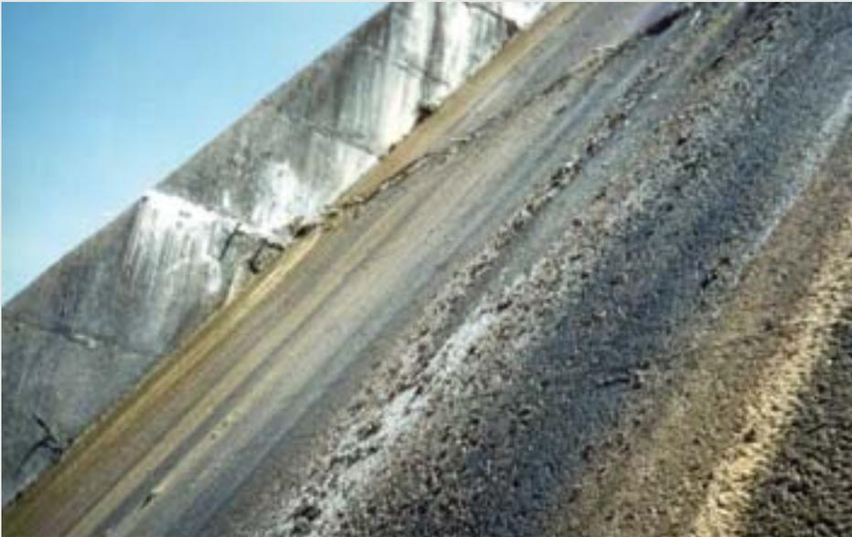
Figura 2 - Muitos vazamentos ao longo do paramento de jusante, com desintegração do concreto...
