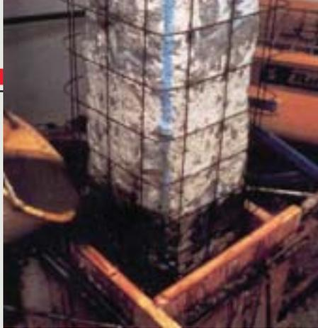
Figura 8 - Antiquada maneira de fazer recuperação (reforço) estrutural motivada por corrosão. O aspecto físico ou mecânico do pilar é 100% privilegiado. O aspecto eletroquímico, que originou o problema, é ignorado. O resultado, embora com o aumento da seção, é um processo de corrosão mais robusto.
