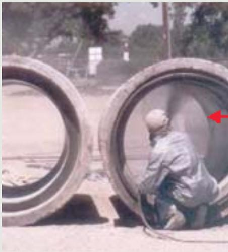
**Figura 9 - A proteção interna de tubulações de concreto armado-protendido torna-se obrigatória. Água ou qualquer outro fluido desencadeia corrosão.**
