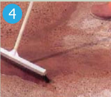
... depois (3) e (4), basta entornar o produto no piso fissurado e espalhar com rodo. Com viscosidade próxima a da água, este adesivo estrutural preenche fissuras da ordem de 0,01mm.
