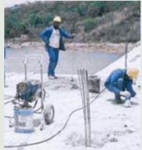
Figura 8 - Bomba de injeção MAX (elétrica) e furos ao longo da crista da barragem.
