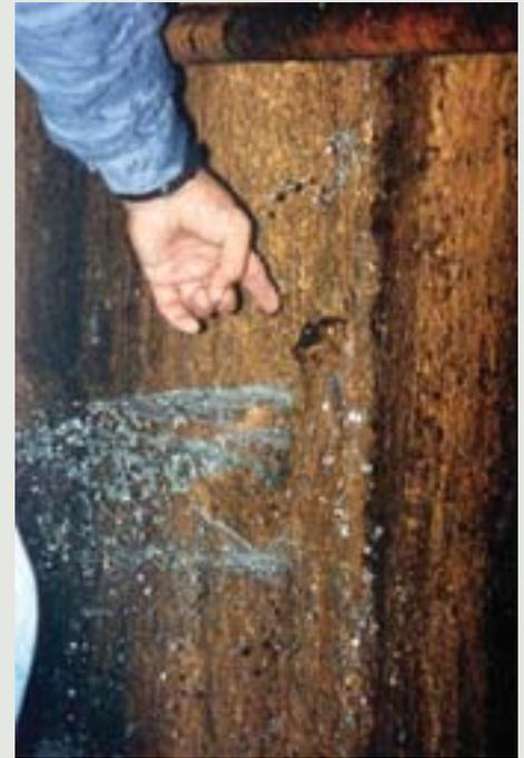
Figura 4 - Grandes vazamentos ao longo das paredes da galeria.
