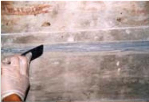
Figura 7 - A aplicação complementar de epóxi estruturante, com espátula, para nivelamento do sulco já com a fita de reforço.
