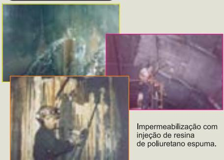
Impermeabilização com injeção de resina de poliuretano espuma.
