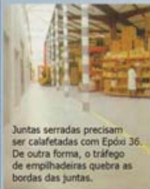
Juntas serradas precisam ser calafetadas com Epóxi 36. De outra forma, o tráfego de empilhadeiras quebra as bordas das juntas.
