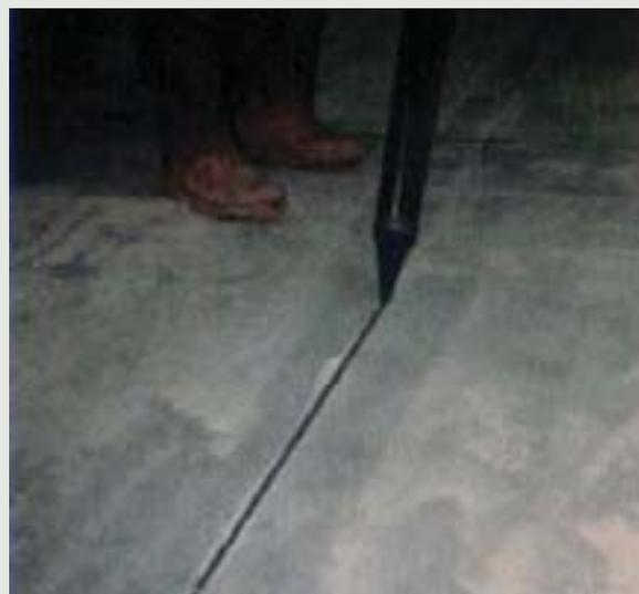
O preenchimento da junta de controle, com epóxi semi-rígido, após o corte.
