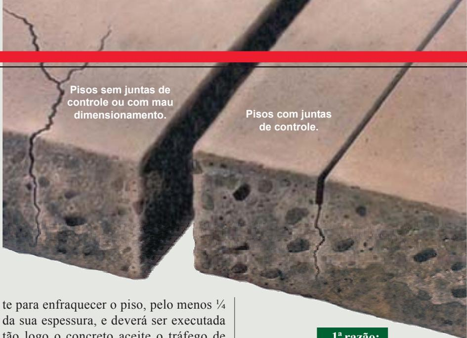
te para enfraquecer o piso, pelo menos 1/4 da sua espessura, e deverá ser executada tão logo o concreto aceite o tráfego de pessoas (e do equipamento), antes que as tensões de tração, que se avolumam, excedam a ainda sonolenta resistência de tração do concreto. A encrenca é que, nem sempre juntas de controle impedem o despontar de fissuras/trincas, e há um caminho de razões. Vamos basculhar quatro principais.
