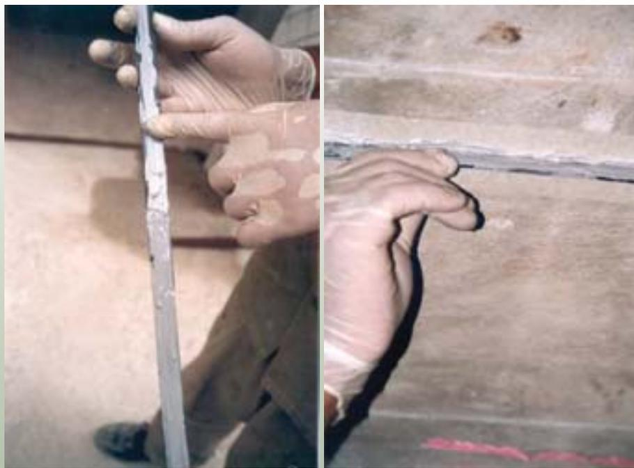
Figura 1 e 2 - A fita de fibra de carbono sendo inserida no sulco previamente preenchido com epóxi. A aplicação do epóxi estruturante em ambos os lados da fita antes de sua inserção no sulco.
