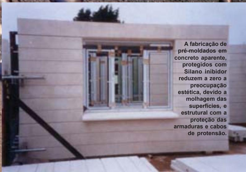
A fabricação de pré-moldados em concreto aparente, protegidos com Silano inibidor reduzem a zero a preocupação estética, devido a molhagem das superfícies, e estrutural com a proteção das armaduras e cabos de protensão.
