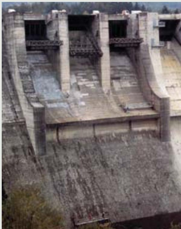
Todo concreto sem revestimento protetor está sujeito a desintegração, motivado pelas reações químicas oriundas da penetração da chuva ácida e de lixiviações constantes. A ausência de proteção adequada ao ambiente exige a execução de trabalhos caros com materiais, muitas das vezes incompatíveis com o próprio concreto original.
