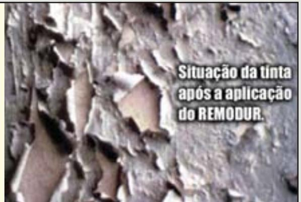
Situação da tinta após a aplicação do REMODUR.
