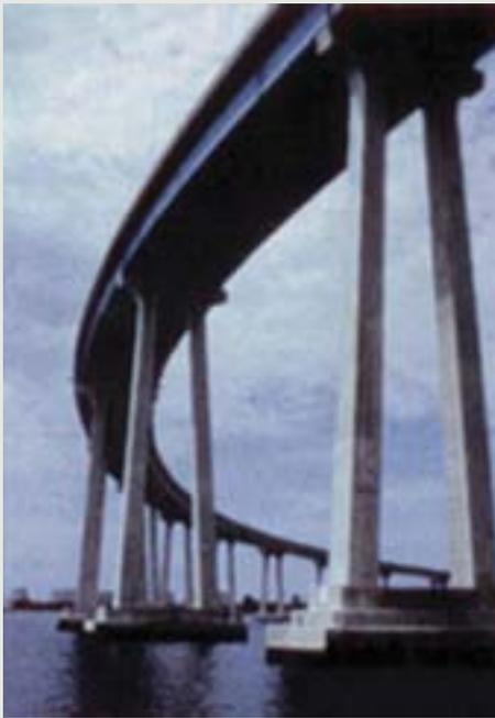
O silano inibidor é aplicado correntemente nas novas estruturas, como nas travessas, pilares e blocos desta ponte.
