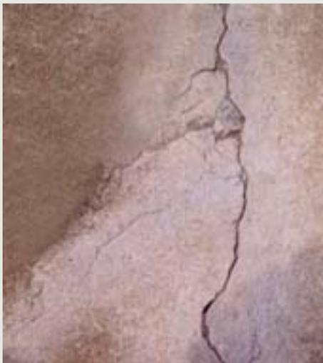
E assim surgem as trincas e fissuras. Repare a quantidade de detritos em seu interior, que devem ser removidos quando se pretende monolitizar o piso com metacrilato.
