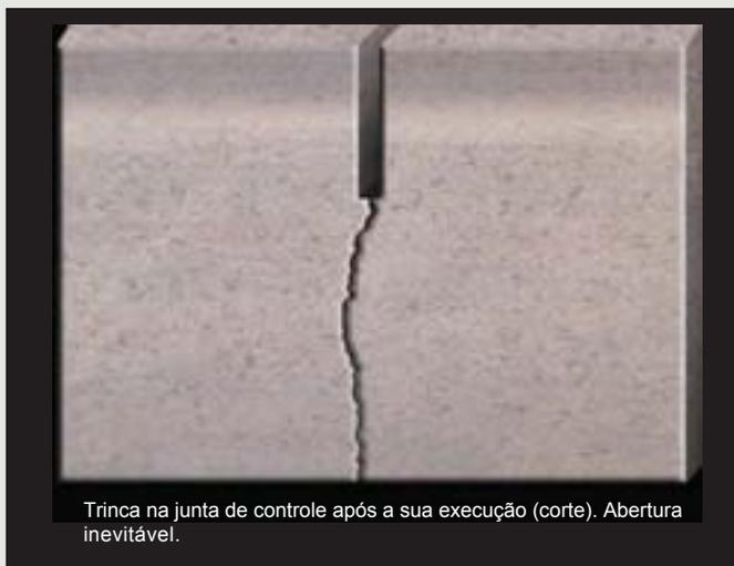
Trinca na junta de controle após a sua execução (corte). Abertura inevitável.
