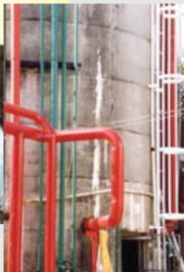
Figura 6 - Situação também muito comum em reservatórios: presença de sais evidenciam a descalcificação do concreto.
