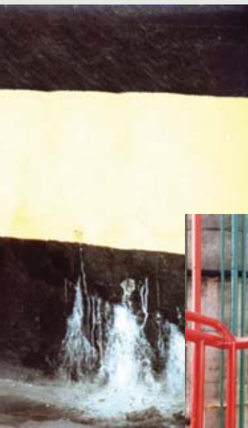
Figura 6 - Situação também muito comum em reservatórios: presença de sais evidenciam a descalcificação do concreto.
