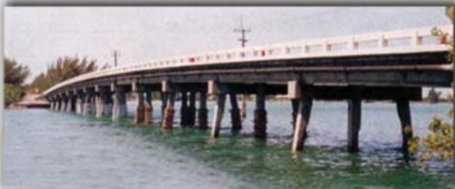
Figura 4 - Ponte com inúmeras estacas de concreto armado com alto nível de corrosão em suas armaduras. A instalação da JAQUETA G com MALHA GALVÂNICA G previamente aderida na própria fibra de vidro.
