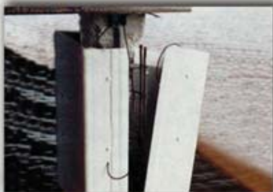
Figura 4 - Ponte com inúmeras estacas de concreto armado com alto nível de corrosão em suas armaduras. A instalação da JAQUETA G com MALHA GALVÂNICA G previamente aderida na própria fibra de vidro.
