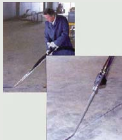
A poliuréia também tem excelentes selantes ou elastômeros para juntas de dilatação. Aderem tenazmente nas bordas do concreto (juntas) e possuem alongamento superior a 600%. Após 30 minutos o piso pode ser liberado.
