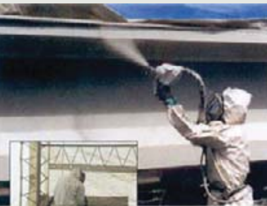
A poliuréia poliaspártica é uma excelente opção para a proteção de peças pesadas expostas ao tempo. Com um mínimo de película, até 150 micrômetros, obtem-se durabilidades superiores a 15 anos.
