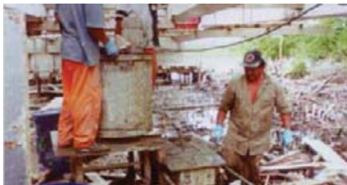
C O grouting em andamento com o misturador alimentando a bomba: diminutos equipamentos.
