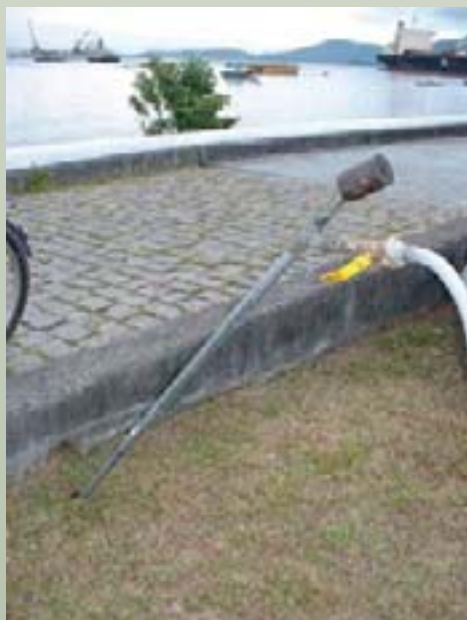
D Detalhe do tubo de injeção posicionado para o tratamento do pavimento de paralelepípedos.
