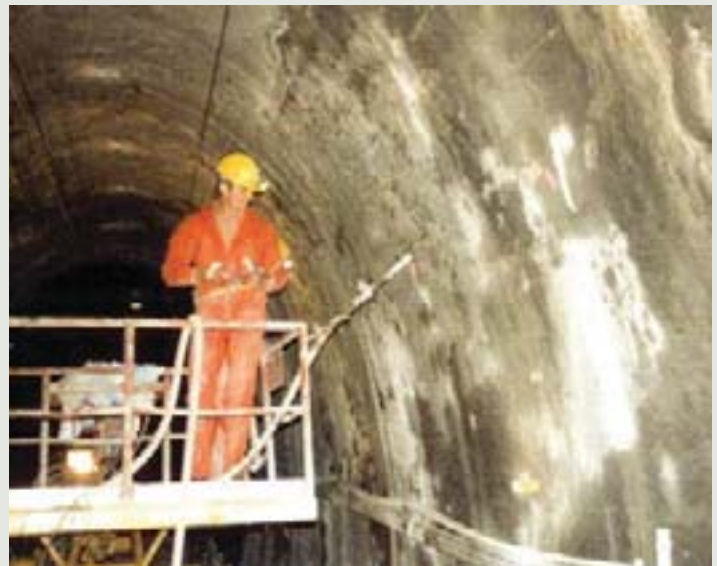
Figura 9 - Grouting impermeabilizante com polímero hidrófilo acrílico na interface concreto/rocha. A rocha é uma perigosa pirita com grande presença d'água.
