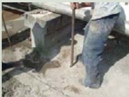
C À esquerda o grouting em andamento. À direita, o início dos serviços.
