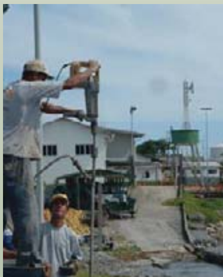
E O grouting em andamento.
