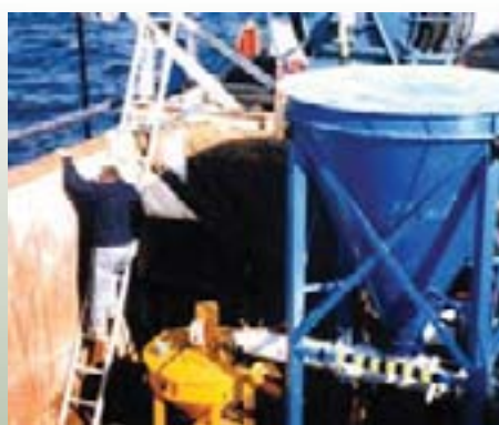
Figura 12 – Consolidação subaquática do solo em torno das estacas de uma ponte, com utilização de microcimento e tempo de pega extremamente curto.
