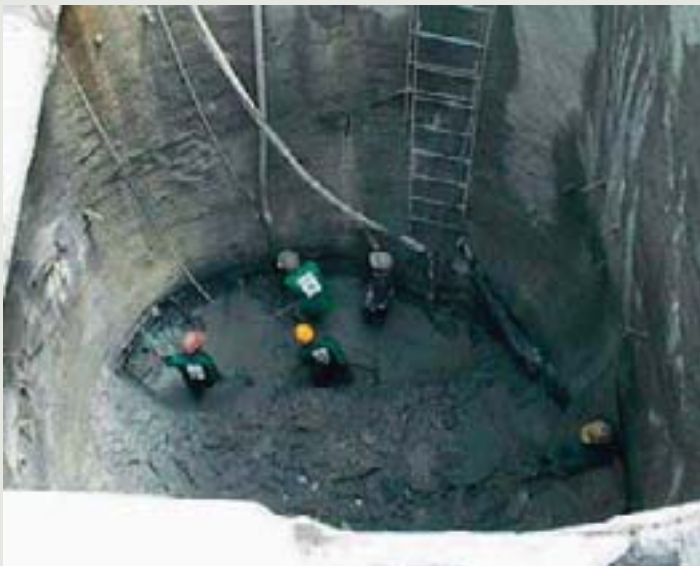
Figura 8 - Grouting sendo feito com argila mole orgânica em um poço de acesso a uma galeria de esgotos, para permitir a continuidade da escavação. Os furos foram feitos radialmente e no fundo do poço.
