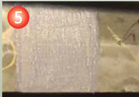
5 Reforço por cisalhamento executado.
