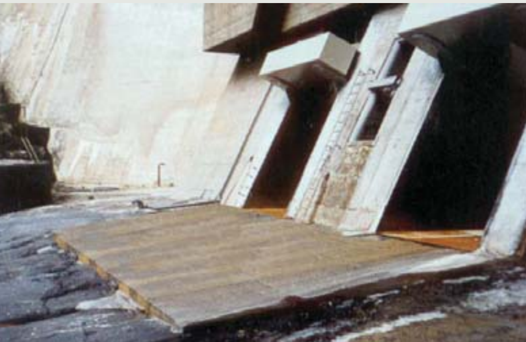
Figura 10 - MCAA nas lajes da barragem GEBIDEM, Suíça.
