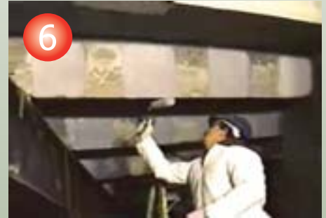
6 Visão panorâmica dos reforços.
