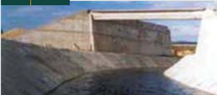
Figura 8 - A superfície do concreto é muito solicitada em curvas de canais.
