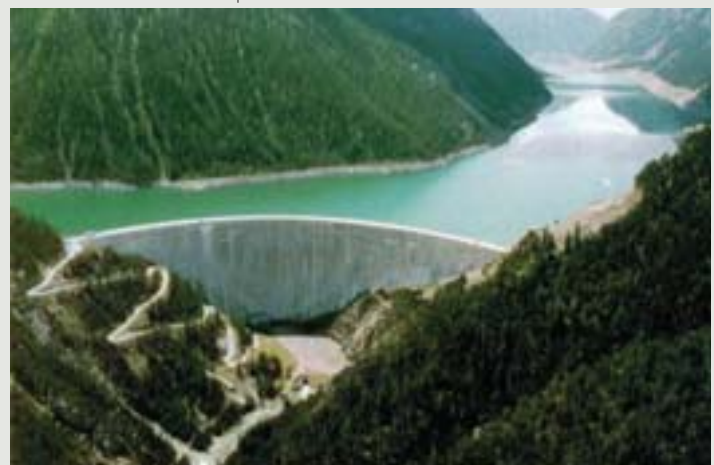
Figura 5 - Outro caso típico em que a laje do vertedouro recebeu o CAA.
