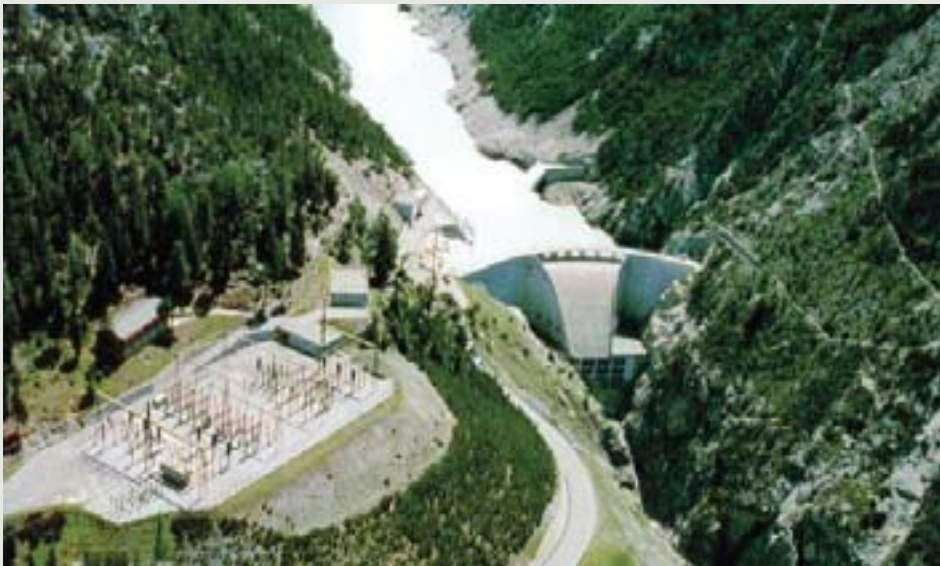
Figura 3 - Barragem típica onde há exigência do CAA no vertedouro.
