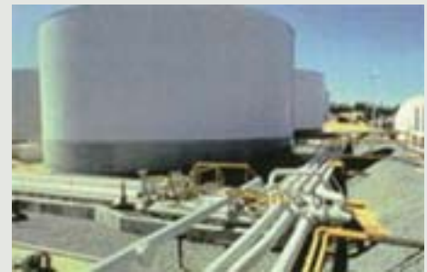
Estocagem secundária em torno de armazenamento de combustíveis ou tanques industriais.
