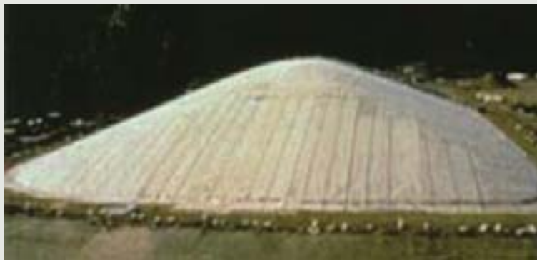
Cobertura de aterro industrial.
