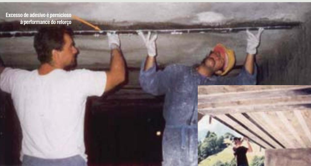
Figura 2 - Laminados de fibra de carbono praticamente deixaram de ser utilizados devido à dificuldade de aplicação, em função da incompatibilidade de posicionamento e colagem com as superfícies (freqüentemente irregulares) das peças estruturais.
