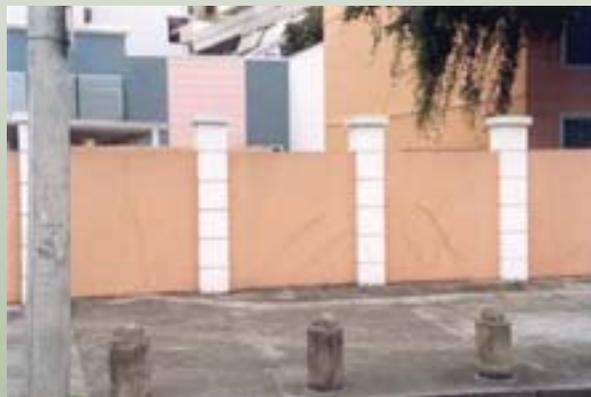
Figura 3B - Problemas com movimentos e distorções entre pilares deste muro. Repare que o do meio está recalçando em relação aos outros dois.
