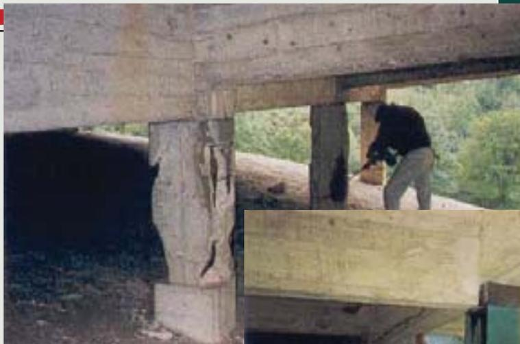
Figura 5 - Estados de corrosão precisam ser totalmente neutralizados com proteção catódica, antes que se proceda o reforço com compósitos.
