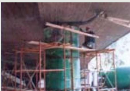
Figura 2 - Para aumentar a seção deste pilar necessitou-se de um concreto auto-adensável especial.
