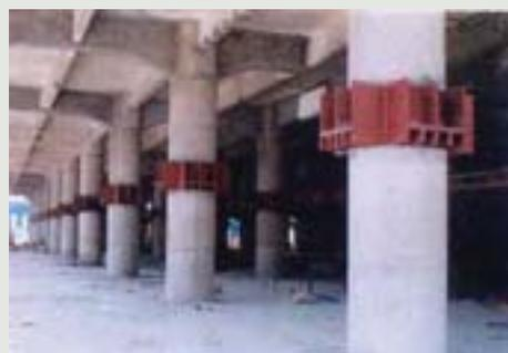
Figura 3 - Aumento, pelo sistema clássico, da seção dos pilares cilíndricos, utilizando-se concreto auto-adensável.
