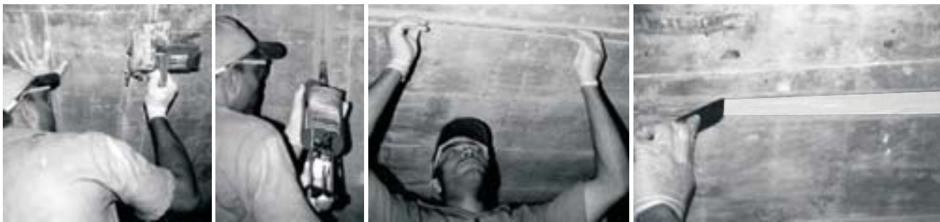
Abre-se o sulco... ...aplica-se o epóxi... ...instala-se a fita e... ...o preenchimento final com epóxi.
