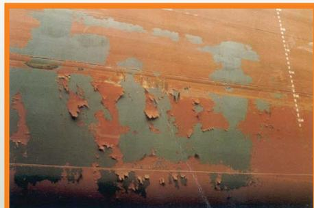
Colapso prematuro da pintura devido a falta de adesão da película, motivado pela contaminação da umidade.
