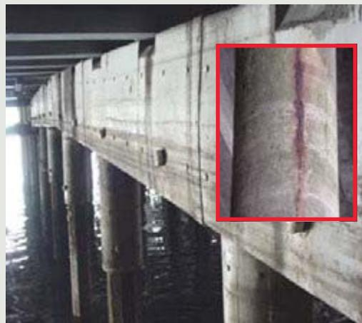
Figura 5B - Ponte Ketchikan. Repare a incidência dos danos devido à corrosão. Após a monolitização com epóxi e o reforço estrutural foi feito o tratamento contra corrosão com JAQUETA G. Figuras 5A e B.
