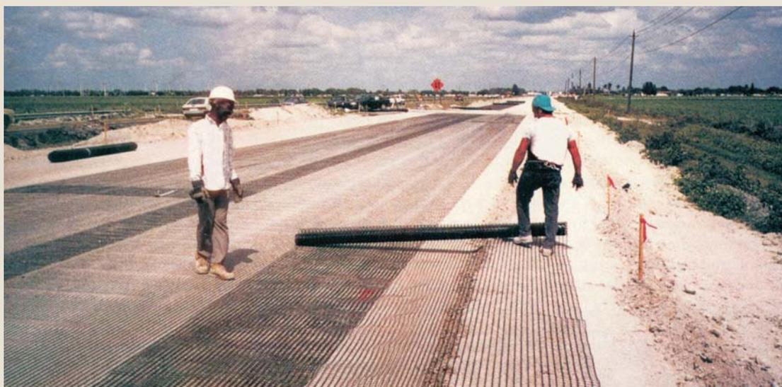
A Geogrelha Biaxial RG reforça solos de fundações (solos moles), encostas e diques, além de resolver problemas de erosão. É a melhor solução para solos sujeitos a cargas repetidas em pistas de aeroportos, estacionamentos, trens etc. A Geogrelha RG diminui significativamente a espessura das bases de tratamento dos pavimentos, otimizando o máximo confinamento do material granular, atuando como armadura de tração e distribuindo cargas sobre áreas bem maiores.
