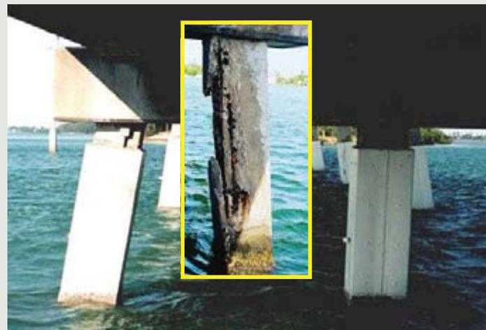
Figura 6 - Ponte da Gasparilla Island Causeway, na Flórida, com 83 estacas comprometidas. O restabelecimento da seção estrutural das estacas foi feito simultaneamente com a concretagem da JAQUETA G. Vinte anos em funcionamento.
