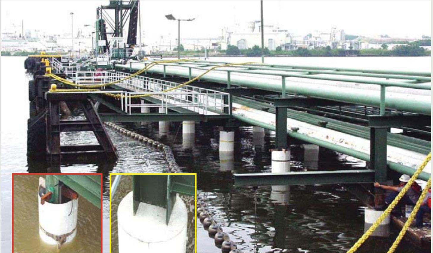
Figura 4 - Estacas metálicas da ponte do terminal de docagem de petróleo, em Baltimore, protegidas com JAQUETA G.
