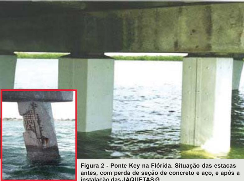
Figura 2 - Ponte Key na Flórida. Situação das estacas antes, com perda de seção de concreto e aço, e após a instalação das JAQUETAS G.
