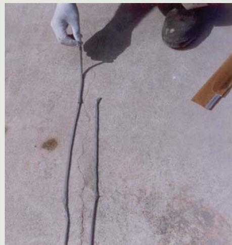
Em trincas localizadas, dever-se-á limitar a trinca com tiras de massa de calafetar ou com elastômero, de modo a verter-se o METACRILATO apenas na região da trinca.
