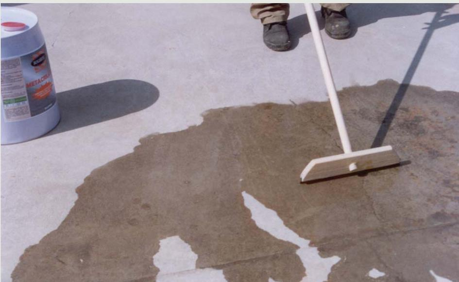
Pisos muito comprometidos com fissuras, trincas e fraturas devem ser tratados abundantemente com METACRILATO.
