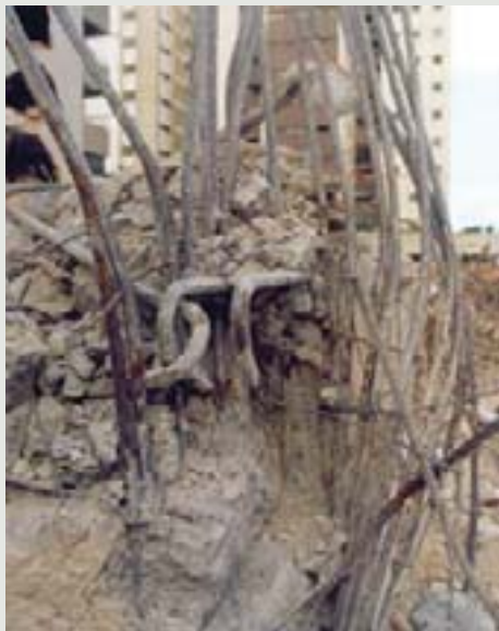
A análise da estrutura do Areia Branca. Na foto à esquerda encontra-se a armadura do pilar central com a armadura da cisterna. Na foto à direita os Eng os Sílvio Andrade e Ana Moura (ambos de frente) do IPACON vistoriando a estrutura.
