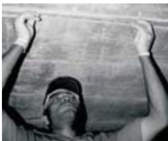
...instala-se a fita e...
