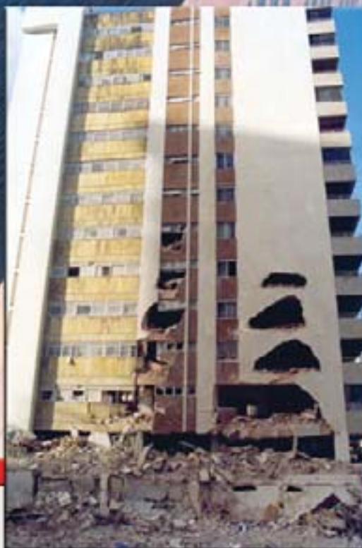
Nos últimos 40 anos muitos prédios desabaram. O último foi o Areia Branca, em Recife. Note que grande parte do entulho foi removido. Observe os danos causados no prédio vizinho, que ainda está interditado.
