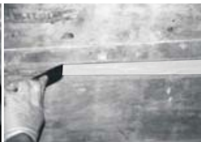
...o preenchimento final com epóxi.
