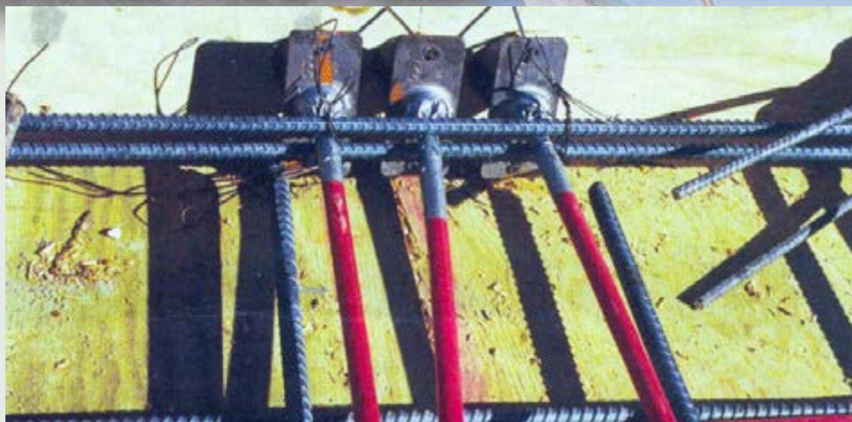
Ancoragem ativa, ou seja, o lado onde executa-se a protensão. Todo este aparato formado por cabos de aço de alta resistência (engraxados e plastificados) e aço comum da construção terá como ambiente comum, o concreto. Trata-se de uma região crítica.
