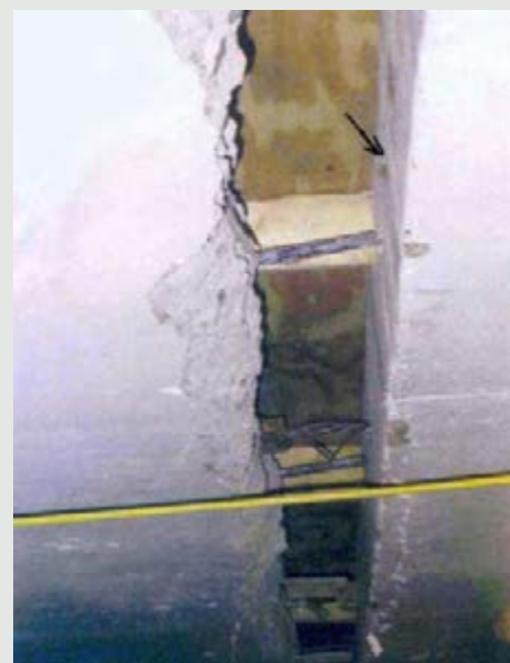
Cabos PT severamente corroídos e/ou partidos na posição de ancoragem intermediária.
