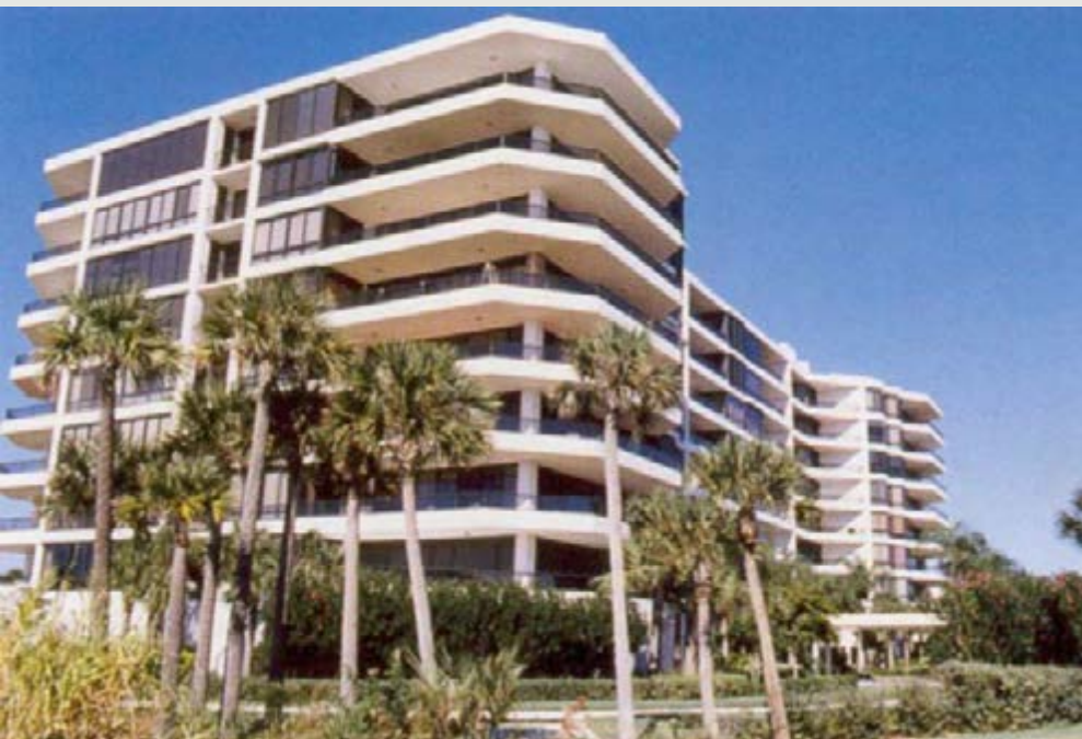
Edifícios à beira mar, invariavelmente, com poucos anos de uso, já apresentam problemas estruturais, devido a corrosão em suas armaduras. Aço no lugar errado? Ausência de prevenção?
