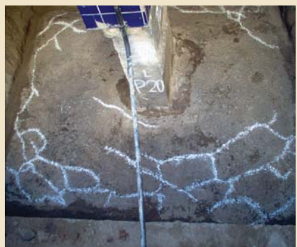
Nesta seqüência de fotos são apresentados 3 pilares com seus respectivos blocos sintomáticos da RAS. Problemas.
