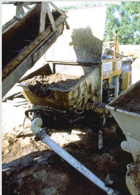
Figura 2 - o sistema de alimentação do grout e a bomba do CG.
