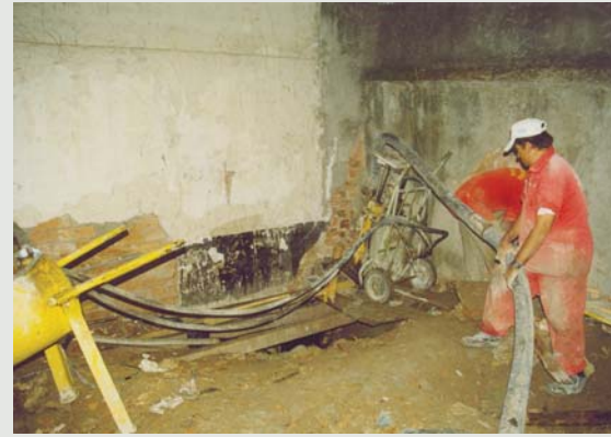
Figura 9 - A mangueira e o arrancador hidráulico informando a posição do tubo do grouting.
