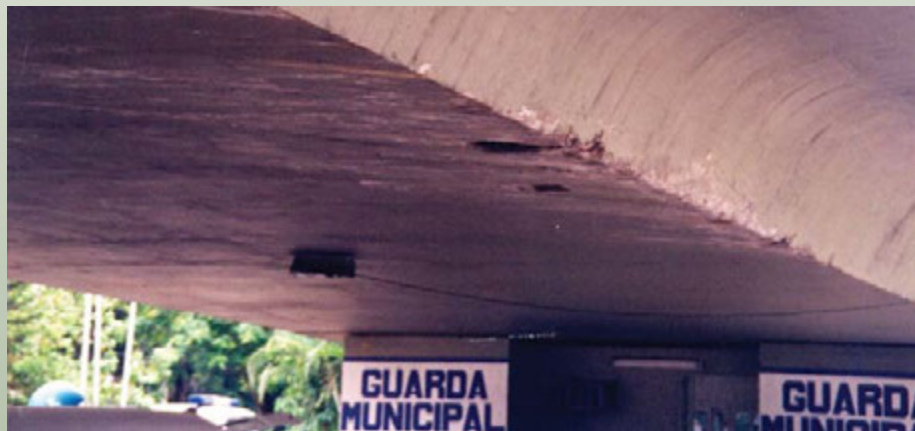
Viaduto túnel Rebouças (RJ).
