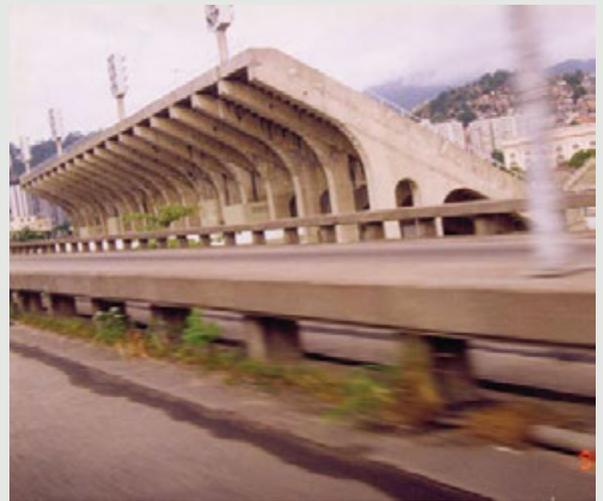
Casos típicos de concreto aparente sem qualquer proteção. O concreto armado é um falso sólido que admite gases e líquidos que ativam o processo de corrosão em suas armaduras.
