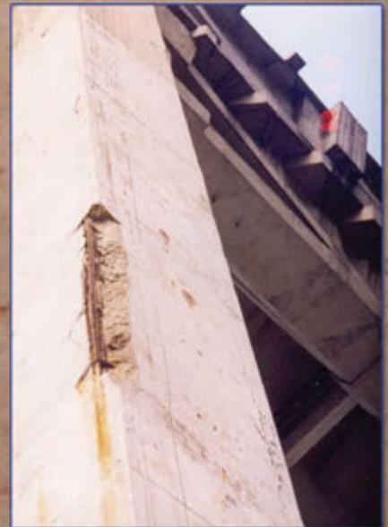
Na foto maior o pilar de uma grande ponte junto ao mar. Nas fotos menores detalhes deste mesmo pilar: concreto aparente em contato direto com a maresia e a própria água do mar sem qualquer proteção – estrutura condenada.
