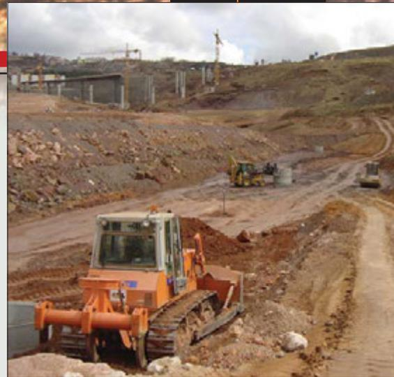
A execução de aterros provisórios sobre drenos verticais.
