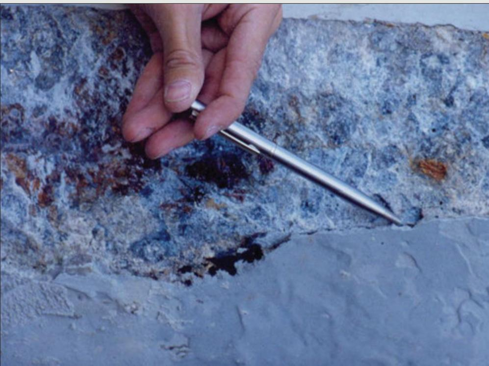
“Pinturas protetoras” que mascaram um verdadeiro estado de corrosão em um pilar de ponte pintado com epóxi. Note as manchas de corrosão no concreto.
