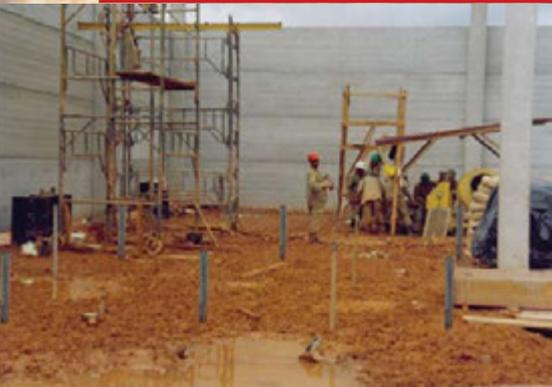
Utilização de drenos verticais profundos e a formação de bulbos e colunas com o Compaction Grouting: melhoria substancial do solo de fundação.
