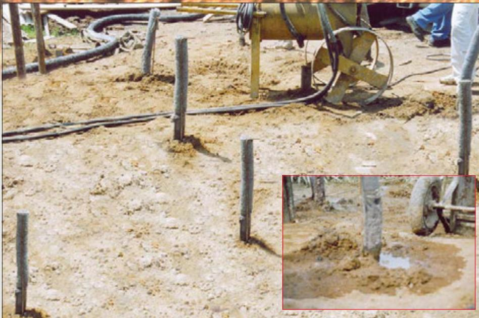
A medida que se promove o Compaction Grouting, ou formam-se bulbos e colunas de grout, os geodrenos purgam imediatamente água: os bulbos geram forças da ordem de 200 toneladas.
