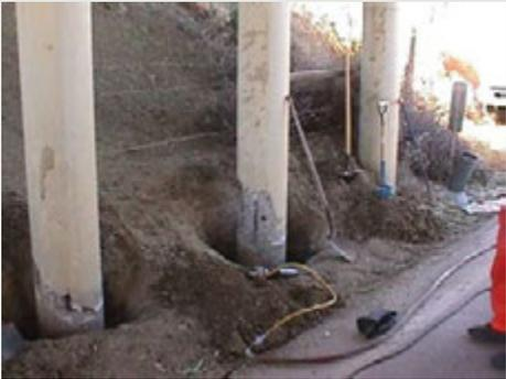
Verificação dos potenciais de corrosão e dos estragos relacionados em pilares de um viaduto.
