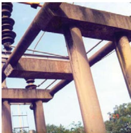
Estruturas esbeltas de concreto armado de estações elétricas é um caso típico onde se constata ausência total de proteção das superfícies do concreto.
