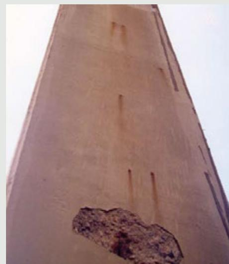
Pites de corrosão neste pilar de uma ponte junto ao mar.
