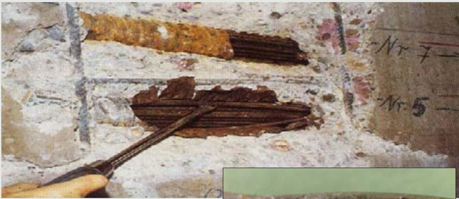
**Cabos de protensão.** Repare no estado da bainha e das cordoalhas. Na foto menor uma cordoalha e seus fios ou o que a corrosão fez com eles. Perda total.
