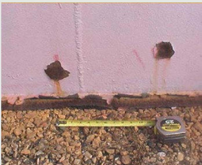
Sério processo de corrosão na chaparia de borda de um tanque de combustível: acúmulo de água nesta região do tanque.
