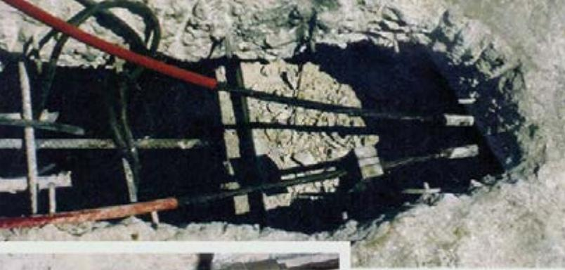
Substituição de cabos: à medida que retira-se o danificado, insere-se o novo.
