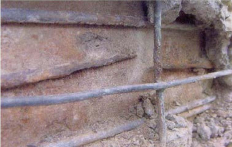
Ausência de monitoramento, para não dizer abandono, fez com que o cabo através das armaduras rompessem. Os demais cabos também.
