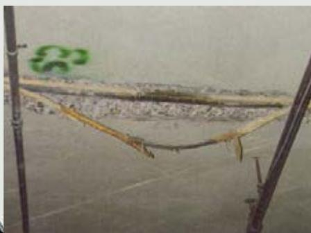
Rompimento de cabo, envolvido em bainha de papel, na região inferior de uma laje. A rutura aconteceu na região de ancoragem.
