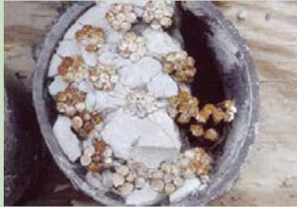
Situação trivial do não preenchimento do cabo. O diferencial de pH nas superfícies das cordoalhas encarregar-se-á de detonar os processos de corrosão.
