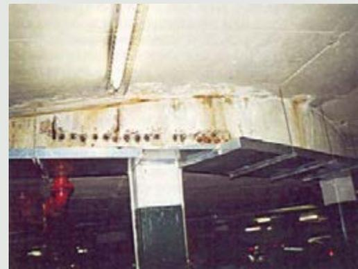
Junta de construção investigada: infiltração d'água e corrosão intensa na região de ancoragem dos cabos de protensão, inclusive com rompimento. A solução impermeabilizante foi com injeção de resina hidroexpansiva PH FLEX.
