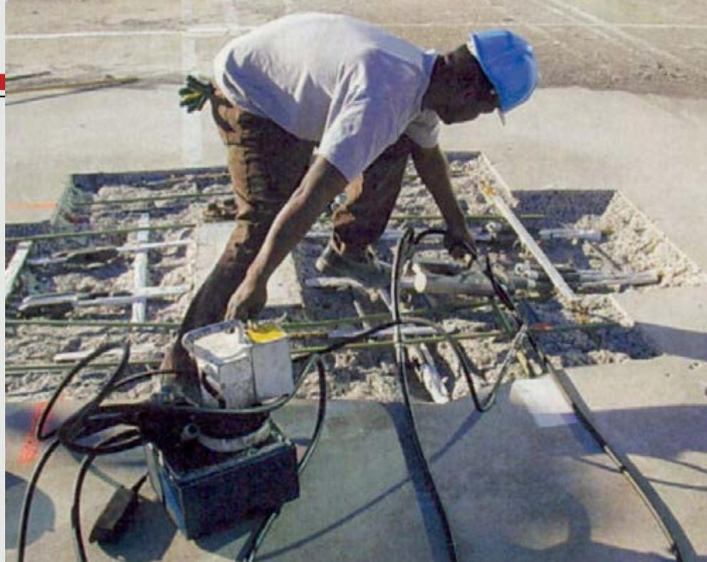
Recuperação de cabos danificados pela corrosão na laje de um estacionamento.
