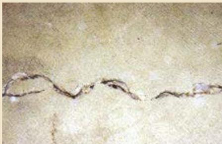
Trincas com abertura em torno de 2mm podem e devem ser obturadas com massa epóxica tipo EPÓXI 44, sem necessidade de fazer o tradicional montinho.
