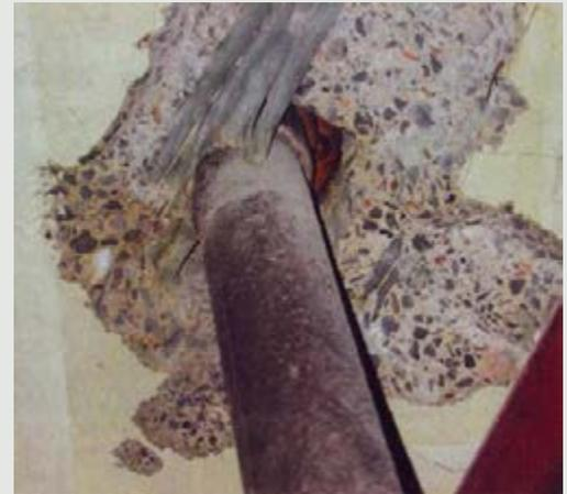
Reforma em prédio: tubulação atravessando a laje e também os cabos, que foram rompidos.
