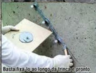
Basta fixá-lo ao longo da trinca e pronto.
