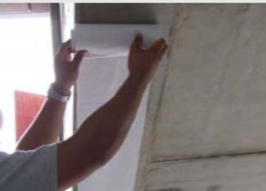
Figura 3 - Um fundo de viga recebendo reforço com o ARMAGLASS. Previamente, foi feita a fresagem da superfície do concreto e a molhagem do ARMAGLASS com água.
