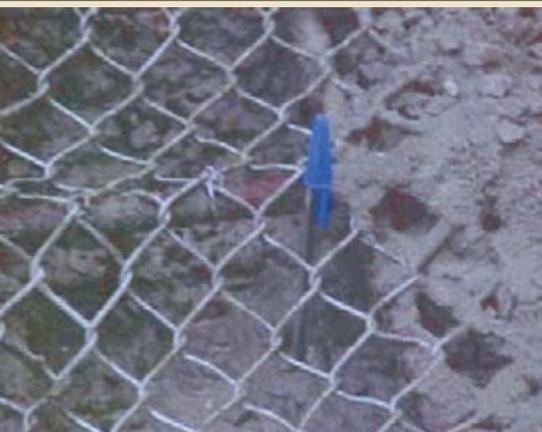
Figura 5 - Após o escoramento e a remoção da camada de recobrimento do concreto antigo, pelo lado interno, instalaram-se novas armaduras, foi colocada proteção catódica com TELA G...
