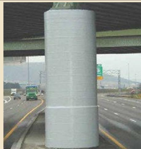
Figura 2 - Pilar com danos provocados por impactos e corrosão em suas armaduras. Após o tratamento das armaduras com proteção catódica com TELA G e a restituição da seção do concreto, fez-se o reforço com o ARMAGLAS, previamente impregnada com água. A impregnação com água, nos primeiros metros, pode ser feita em cima de uma mesa.
