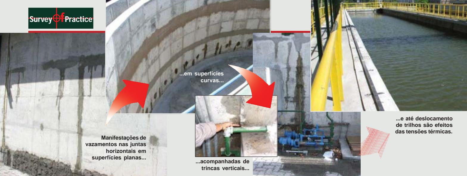
Figura 2 - Tanques com geometrias diversas sofrem terrivelmente o efeito das tensões térmicas: vazamentos generalizados provocados por trincas verticais, nas juntas de construção horizontais, nas juntas laje-paredes, ocasionando também desalinhamentos de trilhos etc...
