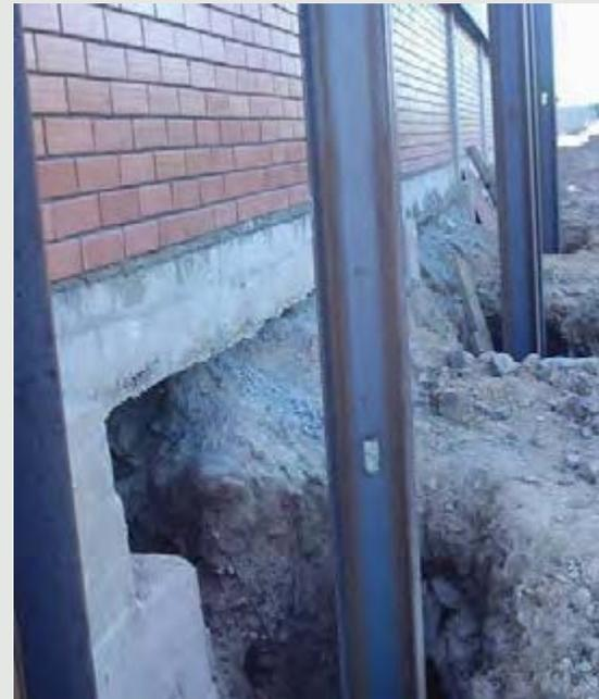
Figura 4 - Estacas metálicas cravadas para tentar conter o efeito do adensamento provocado pelo aterro sobre o solo mole: movimento lateral do sistema paredes/blocos/estacas. Ou seja, o objetivo é apenas tratar os efeitos.
