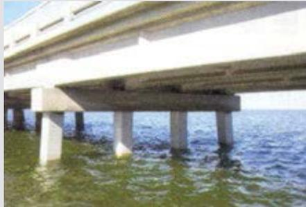
Figura 6 - Como reforço (e revestimento) de estacas após o tratamento da corrosão com a JAQUETA G. O ARMAGLASS pode ser aplicado nas regiões submersas das estacas.
