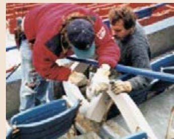
**JUNTA EVAZOTE** é resistente à ação mecânica e química. Ideal para ser aplicada em todo tipo de juntas de dilatação, tanto de pontes como de edificações. Trata-se de uma borracha extremamente resistente ao tempo e ao desgaste abrasivo, sendo totalmente impermeável, formada com copolímeros de polietileno de baixa densidade e acetato de etileno vinílico.
