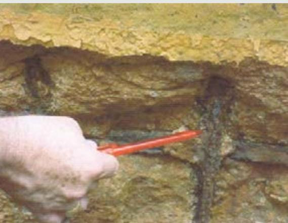
Figura 2 - Parte do tanque com armaduras totalmente comprometidas pela corrosão. Veja o detalhe na foto da esquerda.
