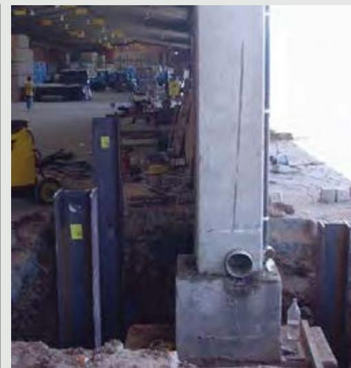
Figura 3 - Detalhe das estacas cravadas pelo lado interno do galpão, esperando para serem cortadas e incorporadas ao novo bloco.
