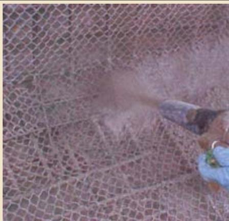
...seguida da projeção de concreto nas paredes do tanque...
