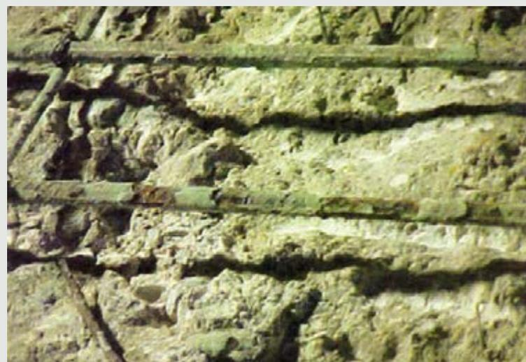
Figura 4 - “Tratamento da corrosão” imposto às armaduras com “pintura inibidora da corrosão com base polimérica”. Repare que o processo de corrosão nas armaduras continuou até a expulsão do revestimento.
