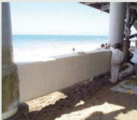
Figura 4 - Enorme viga, que interliga pilares, submetida a batimentos de ondas do mar. Após o tratamento da corrosão nas armaduras com proteção catódica feita com TELA G e a restituição da seção de concreto, promoveu-se o reforço e a proteção com o ARMAGLASS.
