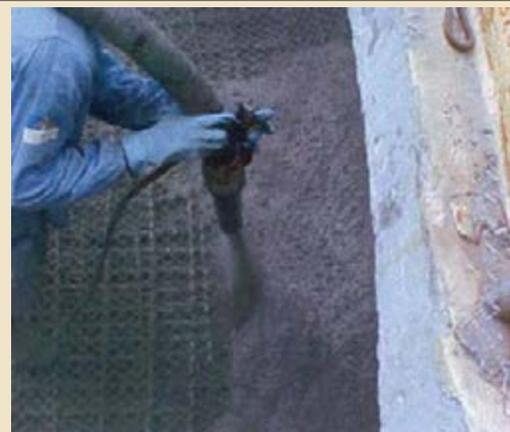
...e no seu piso. Após a cura, repetiu-se o tratamento pelo lado externo do tanque, restabelecendo-se a seção original do concreto.
