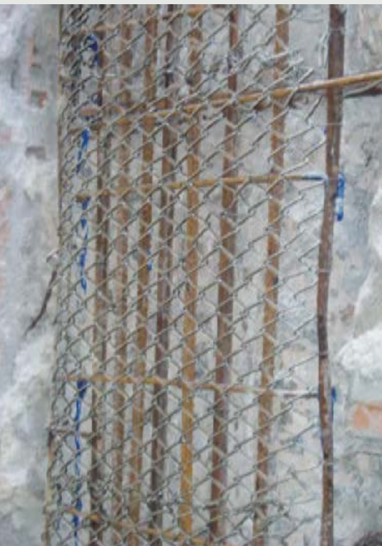
Figura 7 - O uso de proteção catódica com a fixação de tela galvanizada onde houver grande densidade de armaduras, interrompe a corrosão.
