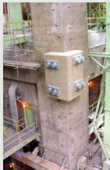
Figura 3 - Todos os furos para os cabos de protensão, em cada um dos níveis da edificação, foram grauteadas, de modo contínuo, a partir das regiões mais inferiores.
