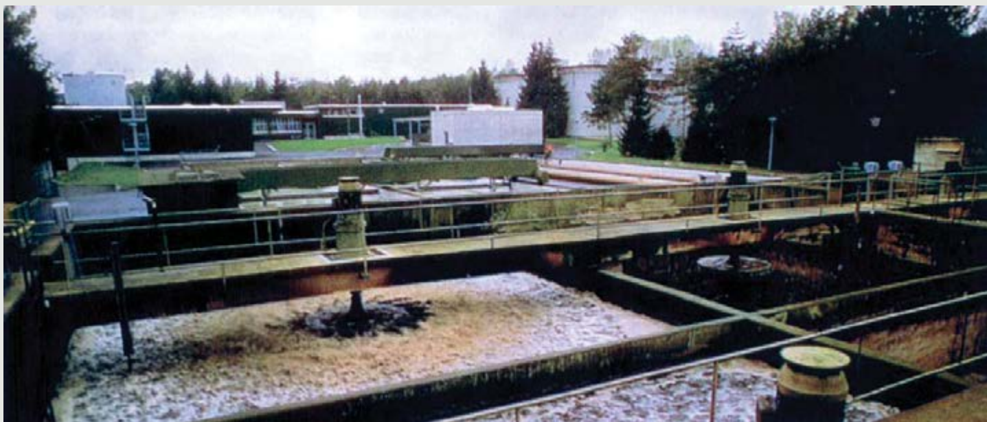
Concreto em contato direto com despejos. Corrosão do concreto e das armaduras a curto e médio prazos.
