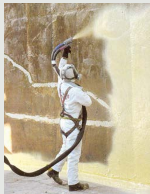
Resinas epóxicas NOVOLAC e à base de POLIURÉIA: resposta eficaz contra a corrosão do concreto armado-protendido.
