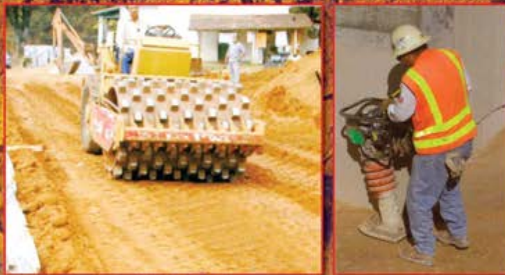
Figura 1 - O rolo “pé de carneiro” e o compactador tipo “sapo” são as ferramentas para trabalho de compactação de subleitos argilosos.
