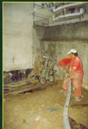
Figura 7 - O uso de proteção catódica com a fixação de tela galvanizada onde houver grande densidade de armaduras, interrompe a corrosão.
