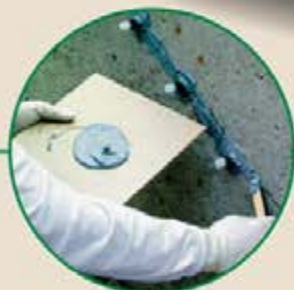
Após o calafetamento das trincas com PASTA EPÓXICA 44 ...
