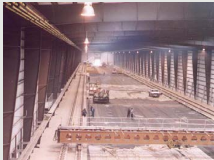
Todo o cuidado é pouco quando da preparação de subleitos com vistas a cargas pesadas submetidas a vibrações.
