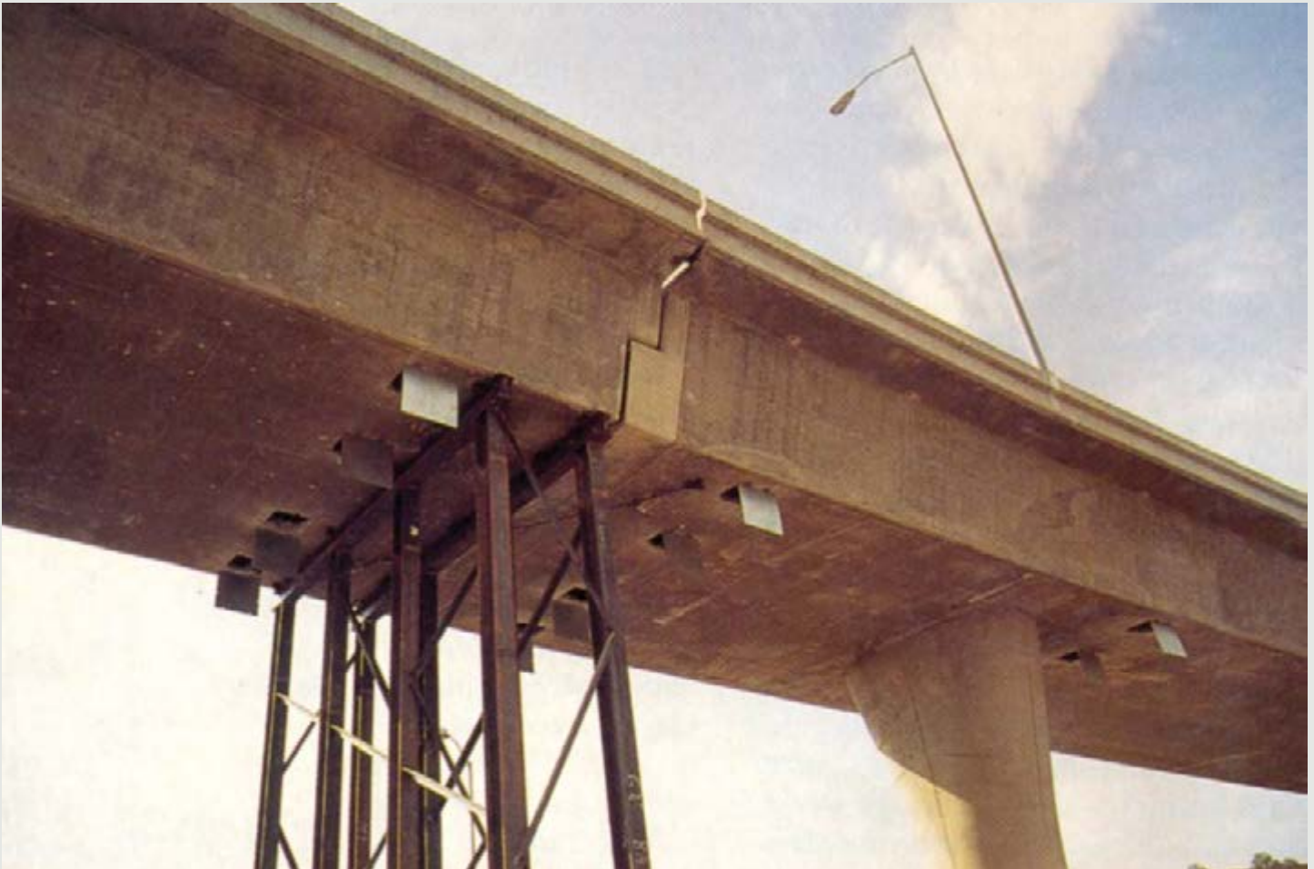
Figura 3 - Durante a recuperação da junta da viga-caixão deste viaduto procedeu-se o escoramento com macaqueamento utilizando-se vigas I contraventadas.
