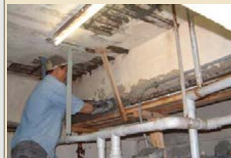
Figura 2 - Situação antes da "recuperação" evidenciando a região com deslocamentos, devido à corrosão e ainda sem tratamento da mesma.
