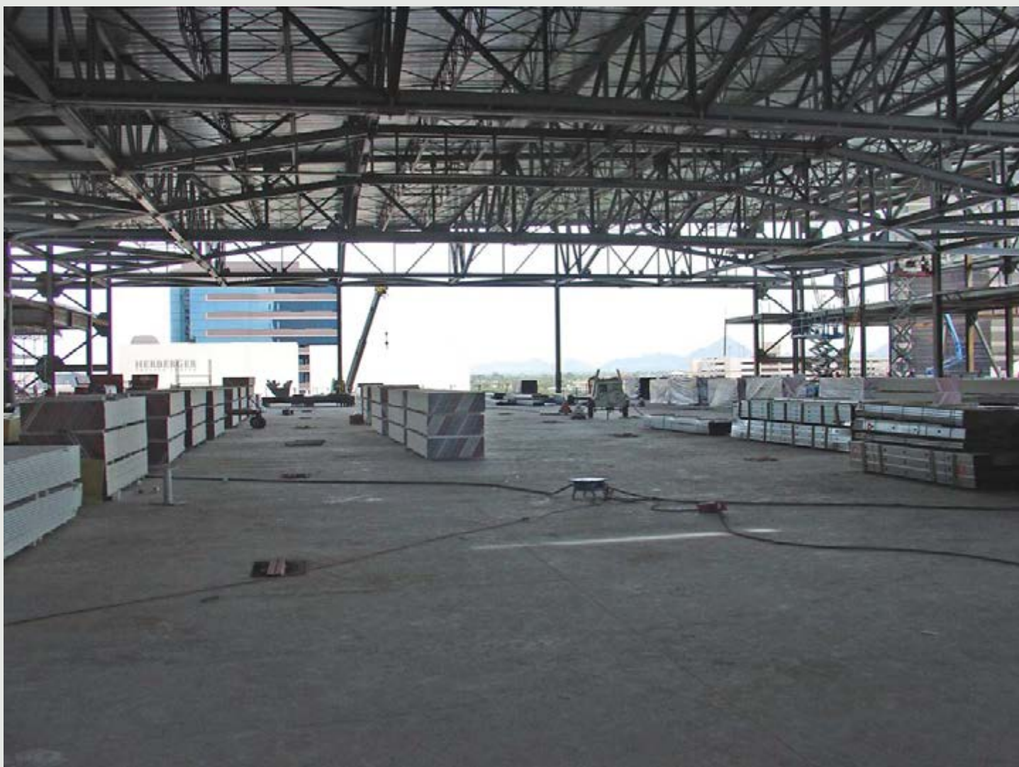
Toda a beleza do piso de concreto dependerá da estratégia e cuidados em sua execução.
