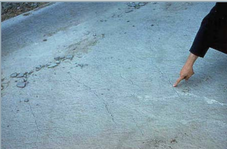
A abertura das trincas de retração é proporcional...
