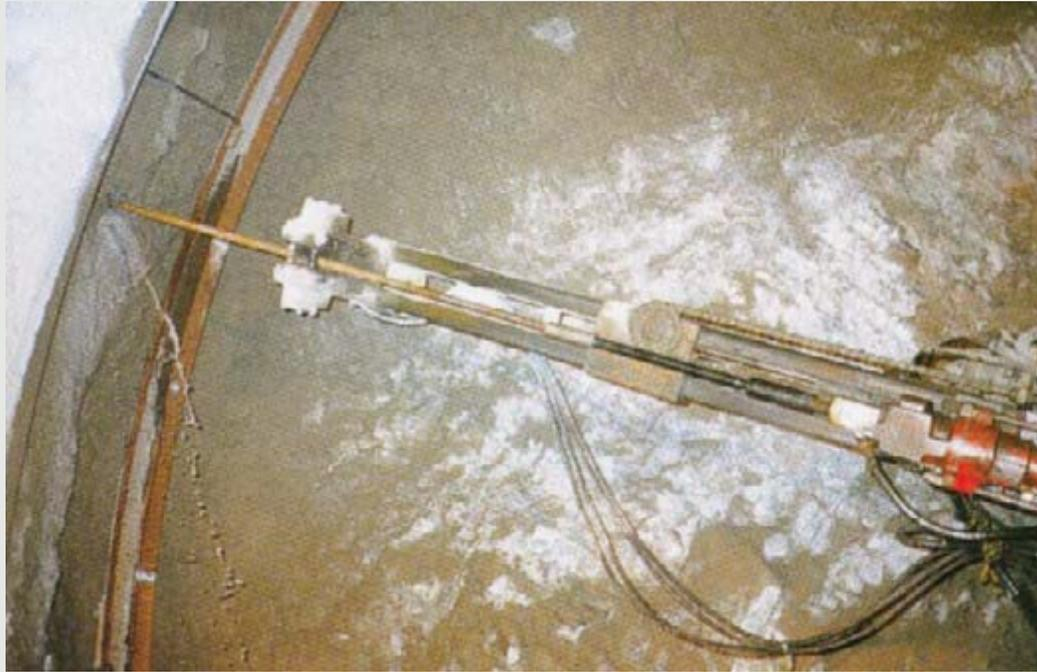
Figura 7 - A presença de água (ácida?) na rocha/solo é crítica para todo o sistema de ancoragem: corrosão.
