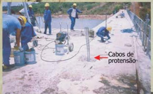
Figura 3 - Cabos de protensão posicionados e furos adjacentes para injeção do PH FLEX.
