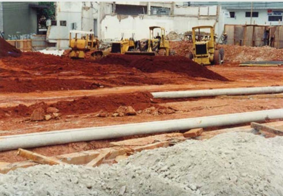
Figura 4 - Estacas para cravação e formação dos blocos periféricos que suportarão o futuro galpão. O material granular que comporá a sub-base também já está no campo.
