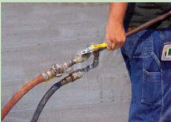
Detalhe para a criação de fogs no local da concretagem. Acople a mangueira d'água à mangueira de um pequeno compressor de ar.
