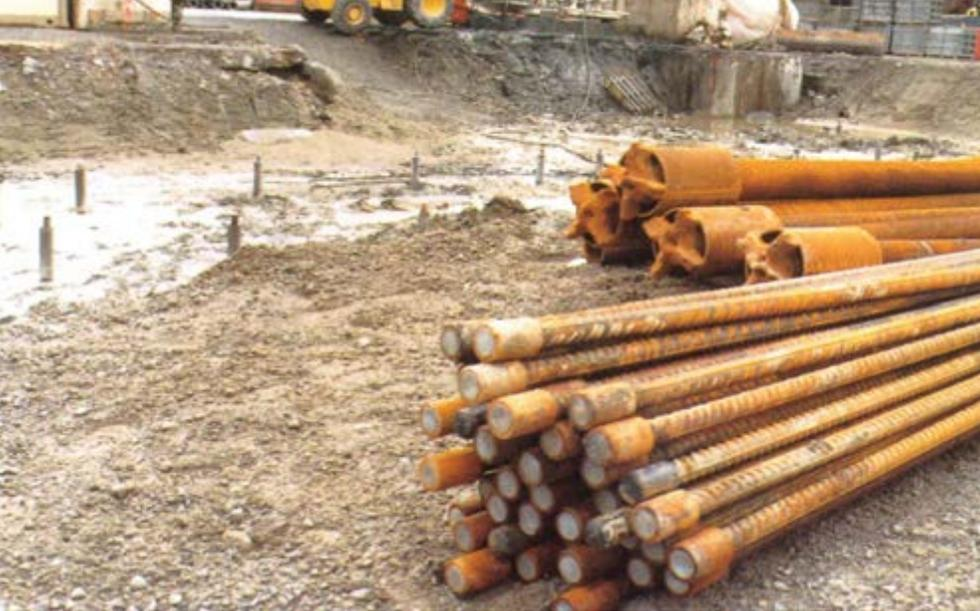
Figura 12 - Tirantes auto perfurantes. A proteção contra a corrosão é obrigatória.
