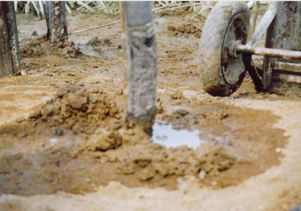
Figura 2 - Terreno de um futuro piso de concreto. A existência de solo mole na sondagem exigiu trabalhos de consolidação por Compaction Grouting e Geodrenos. Os drenos previamente fixados após a injeção do grout neutralizam a pressão neutra.
