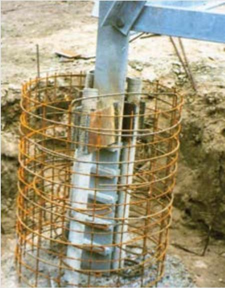
Figura 6 - Situação típica de ancoragem da fundação de torres de transmissão: necessidade de proteger os diversos tipos de aço e seus diferentes potenciais de corrosão: Proteção Catódica com TERRA ANODO G
