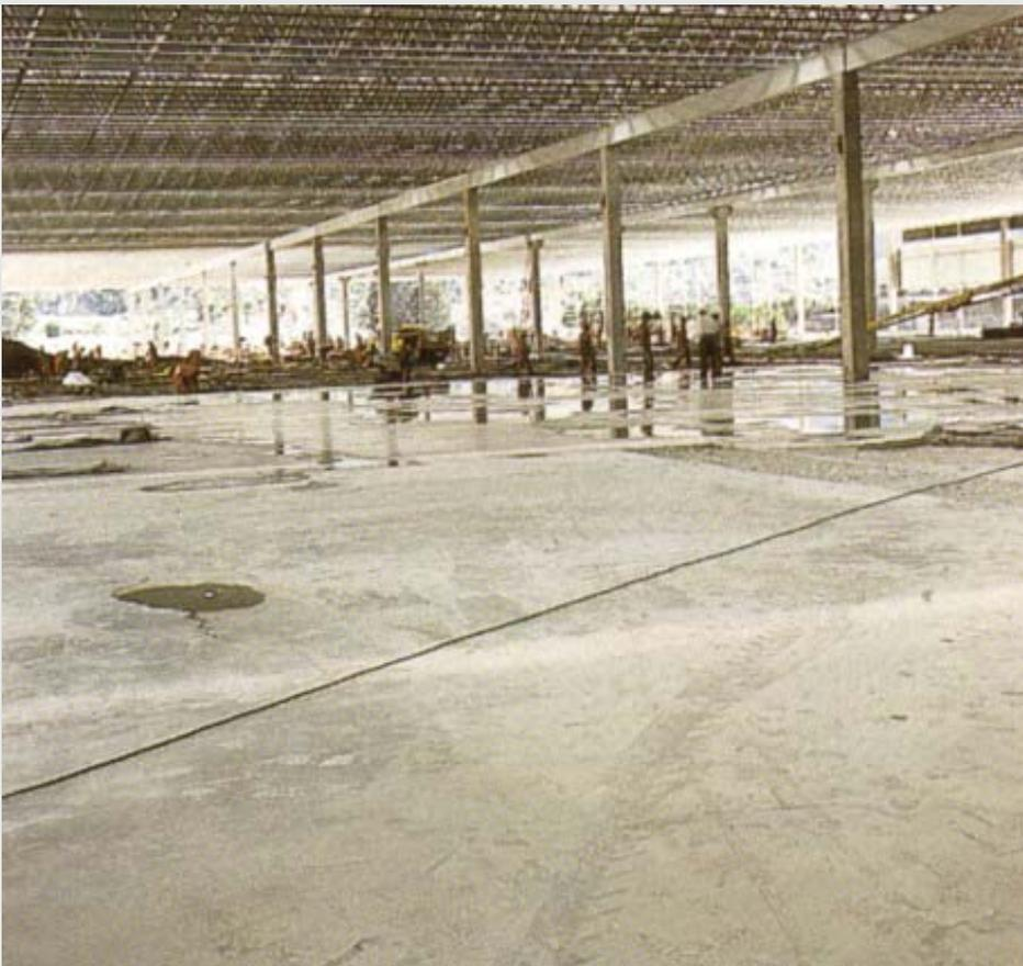
Juntas de dilatação. Fator importante em todo o piso. O correto posicionamento e preenchimento garantirá o perfeito funcionamento das placas.
