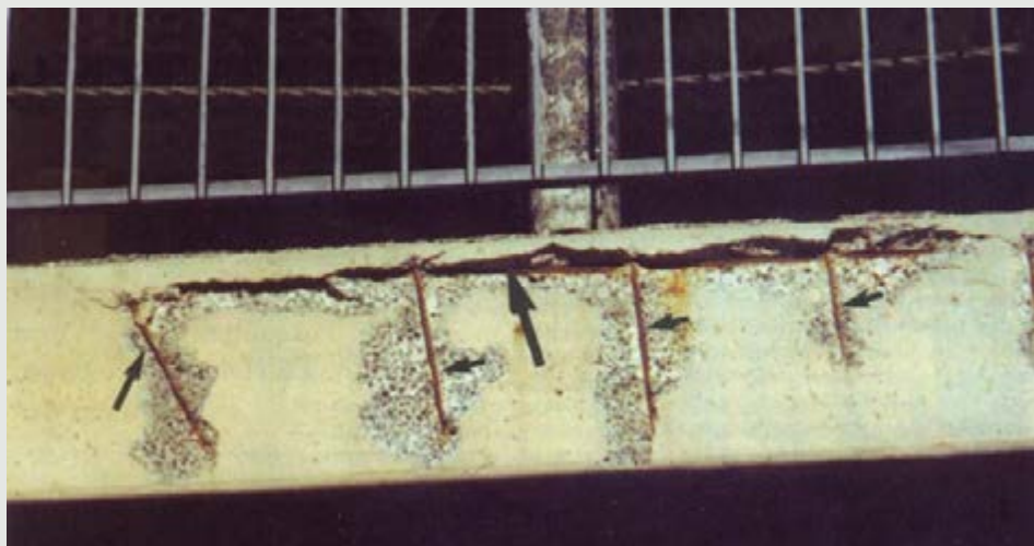
Figura 3 - Viga que sustenta laje de um pavimento industrial. O alto nível de contaminação no concreto afetou profundamente suas armaduras.
