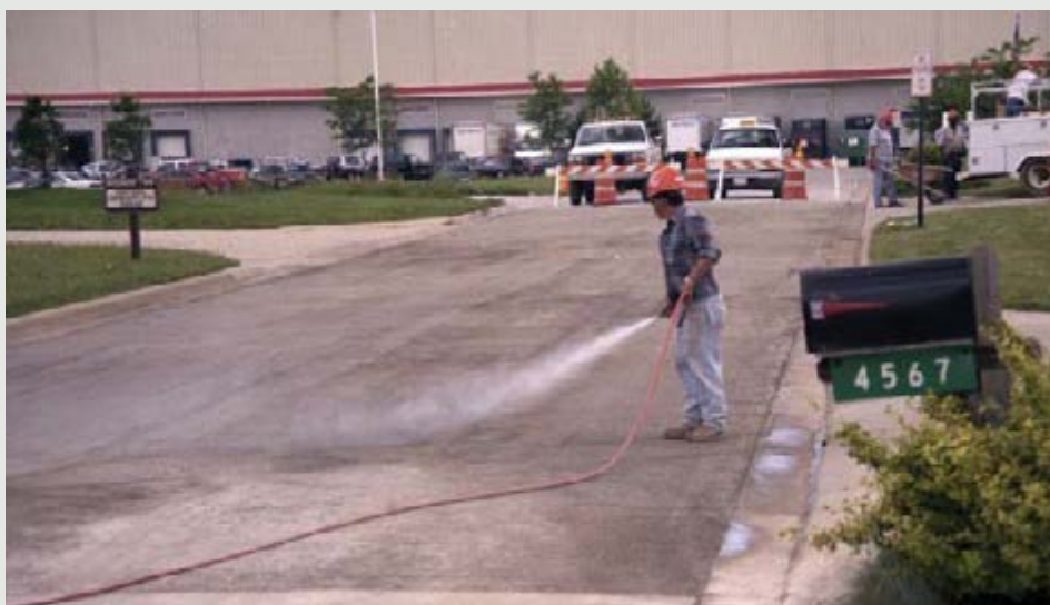
A molhagem do piso após seu endurecimento deverá ser intensa, diária e de acordo com as condições do tempo. O uso de agentes de cura ajuda. A cobertura do piso com tecidos é mais garantida.
