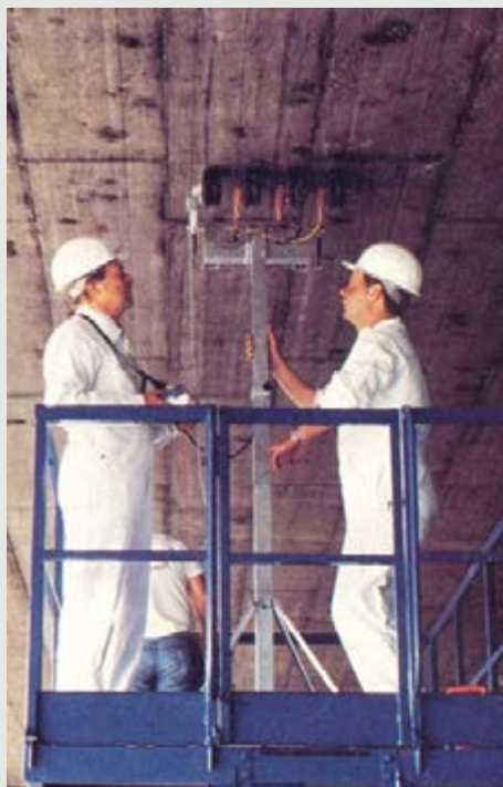
O uso de semi-pilhas pra detectar processos de corrosão já são bastante frequentes nas obras de recuperação do concreto armado-protendido.
