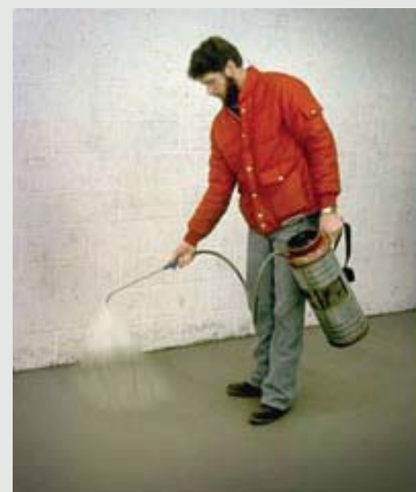
A molhagem do piso após seu endurecimento deverá ser intensa, diária e de acordo com as condições do tempo. O uso de agentes de cura ajuda. A cobertura do piso com tecidos é mais garantida.
