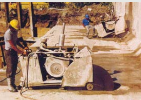
Equipamentos de corte do concreto cada vez mais portentosos nas grandes obras.
