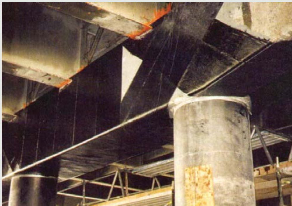
O uso da fibra de carbono nas obras de reforço tornou-se trivial. Assim como seu preço, que despencou. As leis de mercado...
