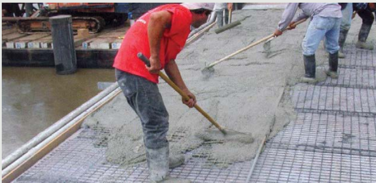
As telas com fios poliméricos evitam uma série de inconvenientes pertinentes às telas de aço.
