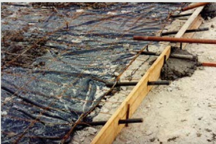
As telas com fios poliméricos evitam uma série de inconvenientes pertinentes às telas de aço.
