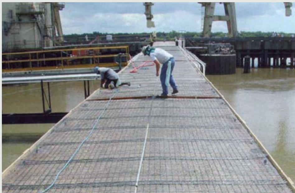
Posicionamento da nova tela sobre a laje deste pier, antes da concretagem, objetivando reforço sem possibilidade de corrosão.
