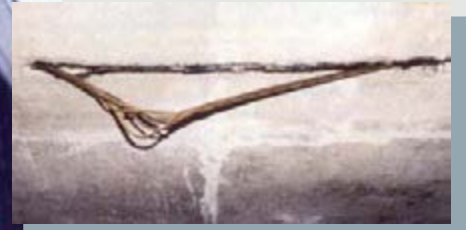
Figura 3 – estacionamento de um shopping - sintomas de rompimento externo de cabos de protensão não aderidos (foto maior) e internamente (foto menor).
