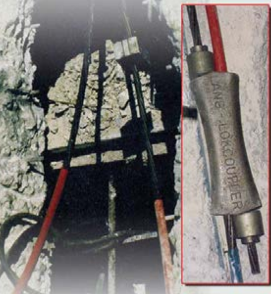
Figura 4 – após a constatação de umidade e conseqüentes potenciais de corrosão comprometedores, o cabo com problemas é retirado à medida que o novo é introduzido. Eventualmente, pode ser feita a introdução de conectores que garantem a emenda dos cabos.
