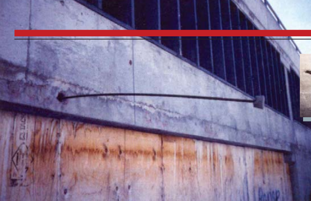
Figura 3 – estacionamento de um shopping - sintomas de rompimento externo de cabos de protensão não aderidos (foto maior) e internamente (foto menor).
