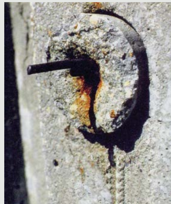
Figura 9 – a quebra do plugue de ancoragem é sinal de rompimento do cabo.
