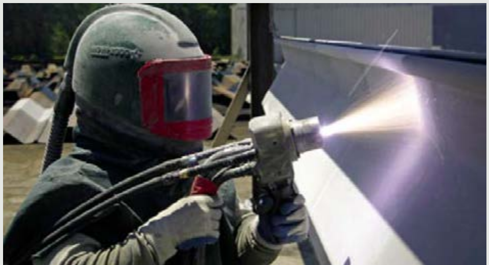
Figura 3 - Aplicação do ZTP na lateral de uma viga.
