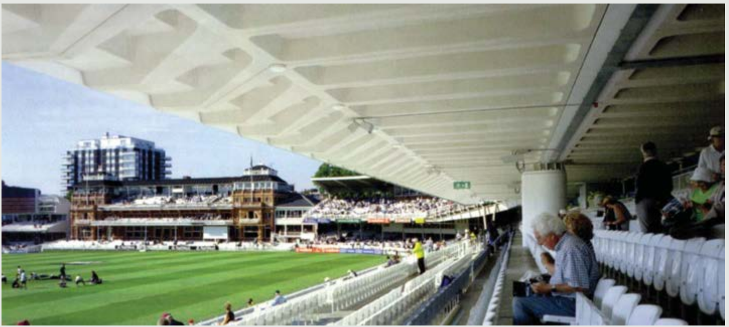
Figura 2 - Estruturas arrojadas de coberturas protendidas de estádios podem e devem ter planos de checagem periódicos.
