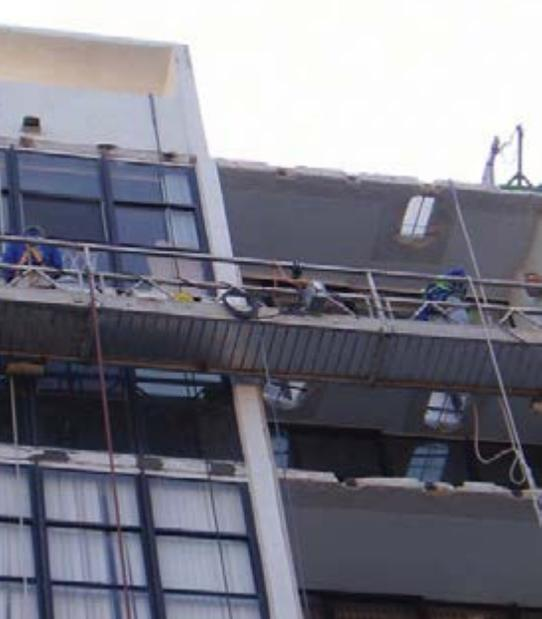
A corrosão motivou a substituição dos cabos de protensão das lajes deste condomínio situado à beira mar.
