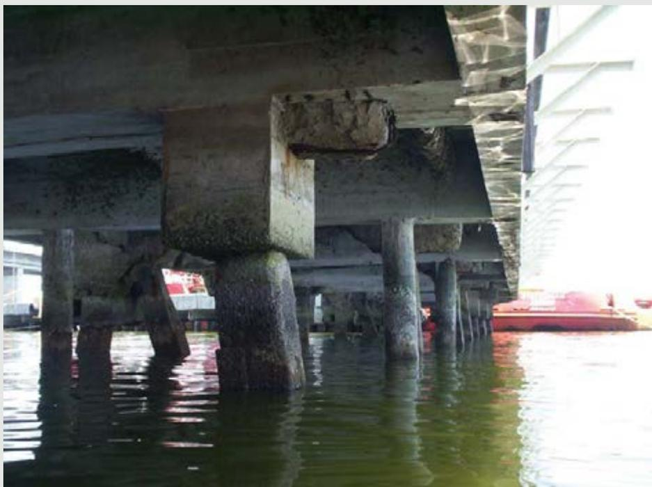
Como é possível construir estruturas de concreto armado em pleno mar sem um plano de seguro, quer dizer, sem um mínimo de proteção tanto para o concreto como para suas armaduras. A química explica.
