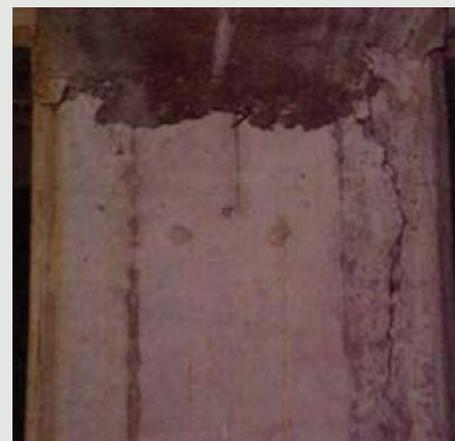
Defeitos de concretagem no topo do pilar, além de umidade intensa devido a presença de água da chuva na laje do 2º subsolo,
