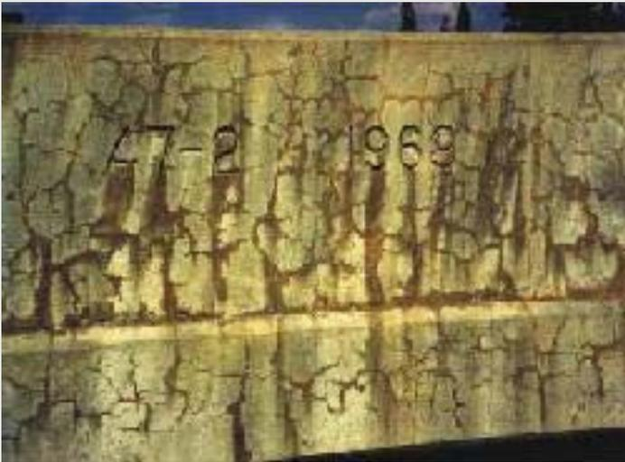
Processo de expansão em marcha devido a RAA nesta peça de concreto armado.
