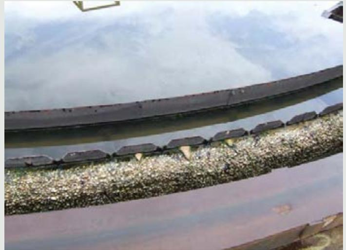
Tanque de decantação de uma ETE. Corrosão do concreto.
