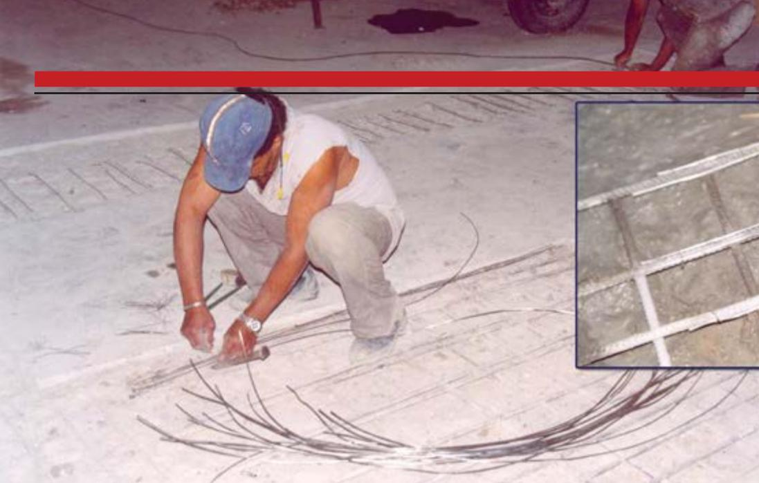
Serviços posteriores de tratamento da corrosão, com FIO G, com diâmetro 4mm. Repare o processo de corrosão insipiente em algumas regiões da laje do 2º subsolo, só detectado com a SEMI-PILHA CPV-4 e o GECOR.
