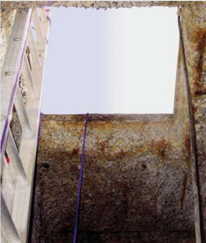
Figura 4 - Estado de um tanque de efluentes ácidos (pH=5), após 3 anos de uso.
