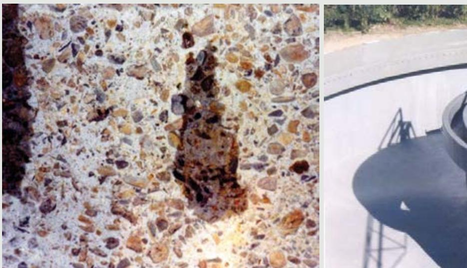
Figura 6 - A superfície deste tanque decantador apresentava-se corroída pelo ataque do efluente. Após a checagem dos potenciais de corrosão com a Semi-Pilha e a instalação de anodos nos locais comprometidos aplicou-se, diretamente com desempenadeira de aço, a massa epóxica novolac, seguida da pintura epóxica novolac.
