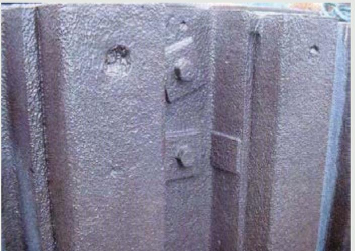
Estacas-pranchas metálicas utilizadas em cais de atracação. Foi preciso algum tempo para que a estrutura mostrasse sua fragilidade à corrosão e, após serviços de preparação das superfícies fosse protegida com ZTP.
