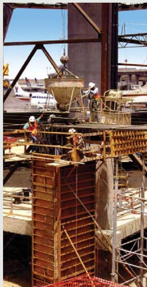
Figura 8 - Condição difícil de concretagem. Lançamento com altura elevada e grande concentração de ferros.
