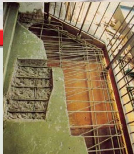
Figura 2 - Ferragem negativa mal posicionada. A solução para este caso foi a demolição do concreto para reconcretagem.
