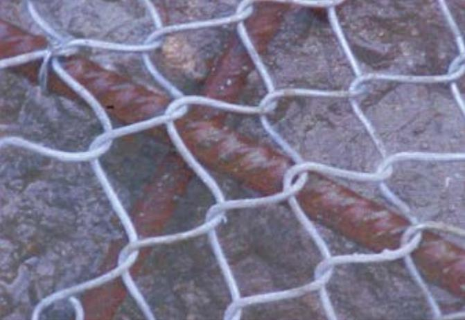
Figura 5 - Proteção das armaduras da laje de um tanque de produtos corrosivos com TELA G, durante a concretagem.
