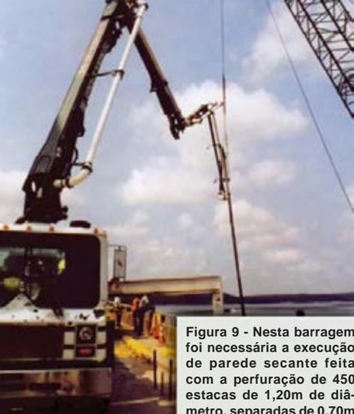
Figura 9 - Nesta barragem foi necessária a execução de parede secante feita com a perfuração de 450 estacas de 1,20m de diâmetro, separadas de 0,70m
