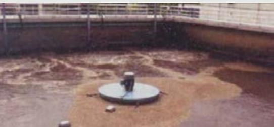
Figura 2 - Reatores biológicos são locais que exigem extrema cautela na proteção do concreto armado-protendido, devido ao tipo de efluente que contém e ao seu processo de aeração e mistura.
