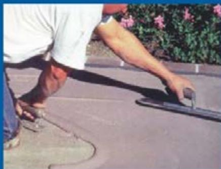
Só adicionar água. Pega rápida em 30 minutos. Liberação para tráfego em 6 horas. Regularização de pisos comerciais e industriais, estacionamentos. Com 6 horas possui 12MPa.
