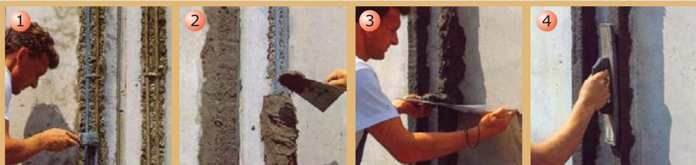
Figura 9 - Seqüência recuperativa muito comum. Pintura das barras e aplicação da argamassa polimerizada. Resultado: prática totalmente equivocada de recuperação, com durabilidade comprometida, tanto pelo aspecto físico quanto pelo eletroquímico da corrosão.
