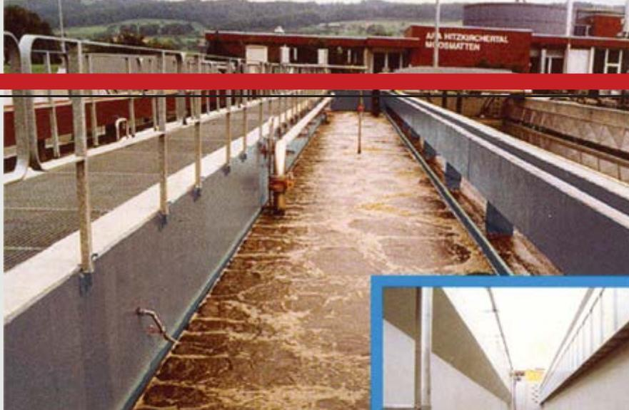
Figura 3 - Tanque, foto maior e menor, de aeração tratado com epóxi novolac 100% sólido enriquecido com fibras. Tratamento adequado.
