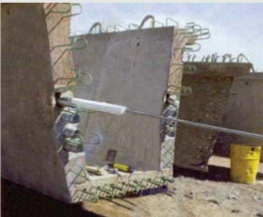
Figura 2 - A viga caixão analisada e o modelo da meia lua de isopor inserido.
