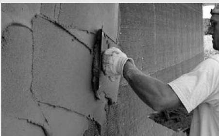
Figura 3 - Tixotropia é uma das características marcantes das argamassas de recuperação.
