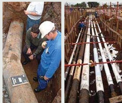
A presença de sais solúveis, especialmente cloretos e sulfatos na interface aço/pintura causa deterioração prematura da barreira de proteção. A grande questão é saber a concentração salina existente.
