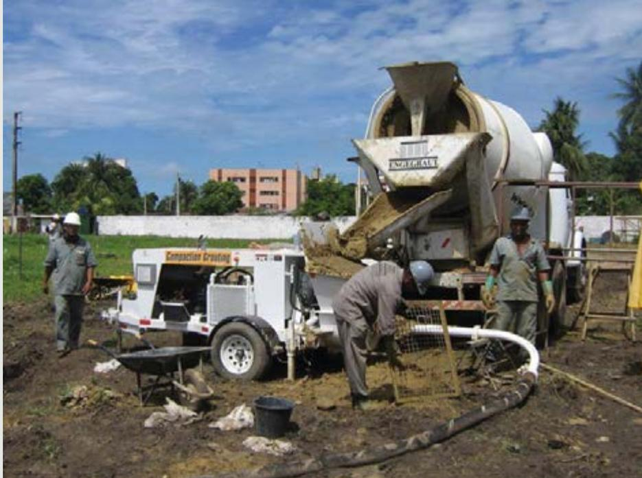
CPR sendo executado em uma área de 30mil metros quadrados em Recife, em uma camada de solo mole de 8m de profundidade.
