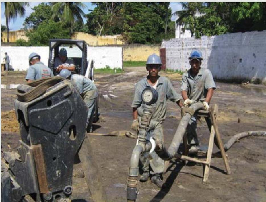
CPR sendo executado. Em primeiro plano o tubo que adentra no solo com seu manômetro que informa a tensão imposta ao solo na profundidade do bombeamento.
