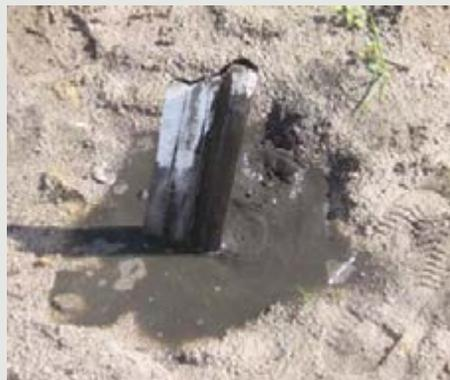
Lenta dissipação do excesso de poropressão, em torno do geodreno, 10 dias após a execução do CPR.
