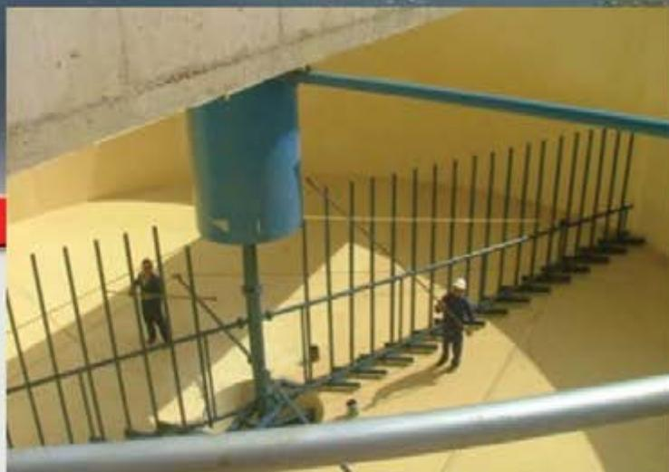
Figura 2 - Pinturas protetoras devem ter agentes específicos de proteção física e biológicas que impeçam o depósito biológico.
