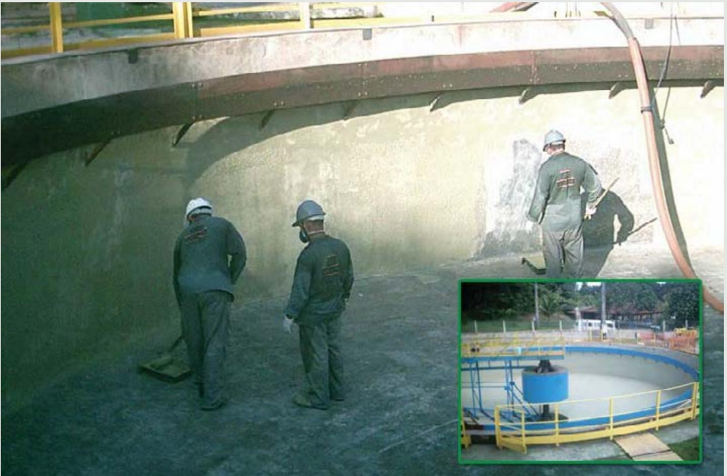
Pintura de proteção com epóxi novolac no interior do tanque de uma estação de tratamento de efluentes industriais. Na foto menor, o serviço realizado. A preparação das superfícies e o primer são fundamentais para a durabilidade da proteção.
