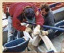
**JUNTA EVAZOTE** é resistente à ação mecânica e química. Ideal para ser aplicada em todo tipo de juntas de dilatação, tanto de pontes como de edificações. Borracha extremamente resistente ao tempo e ao desgaste abrasivo, totalmente impermeável, formada com copolímeros de polietileno de baixa densidade e acetato de etileno vinílico. Colada com epóxi EVAPÓXI é superior a todas as juntas do mercado. **NÃO PRECISA INJETAR AR.**
