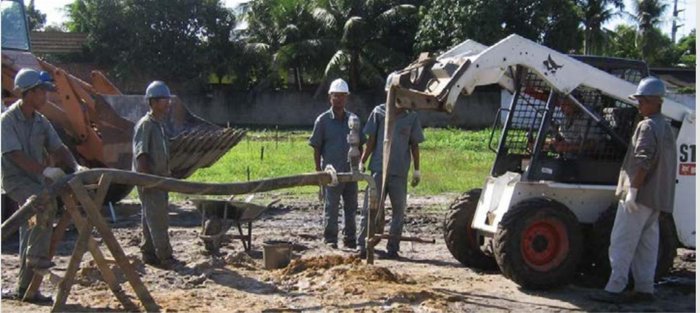
A consolidação do solo em andamento com o bombeamento do CPR neste terreno onde há uma capa de aterro com 0,80cm e 8m de solo mole abaixo.
