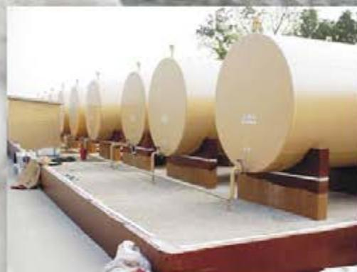
O **Piso-Dur NO CORR** é um revestimento cimentício (cimentos especiais) moderníssimo que atende a norma NBR-17505-2 para proteção secundária em bacias de tanques industriais que estocam óleos orgânicos/inorgânicos ou corrosivos.
