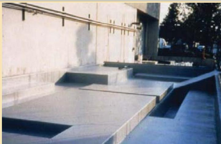
Tanques e produtos altamente corrosivos geralmente deverão ter a proteção secundária na forma de bacias protegidas com revestimentos bem dimensionados para resistir ao ataque químico.
