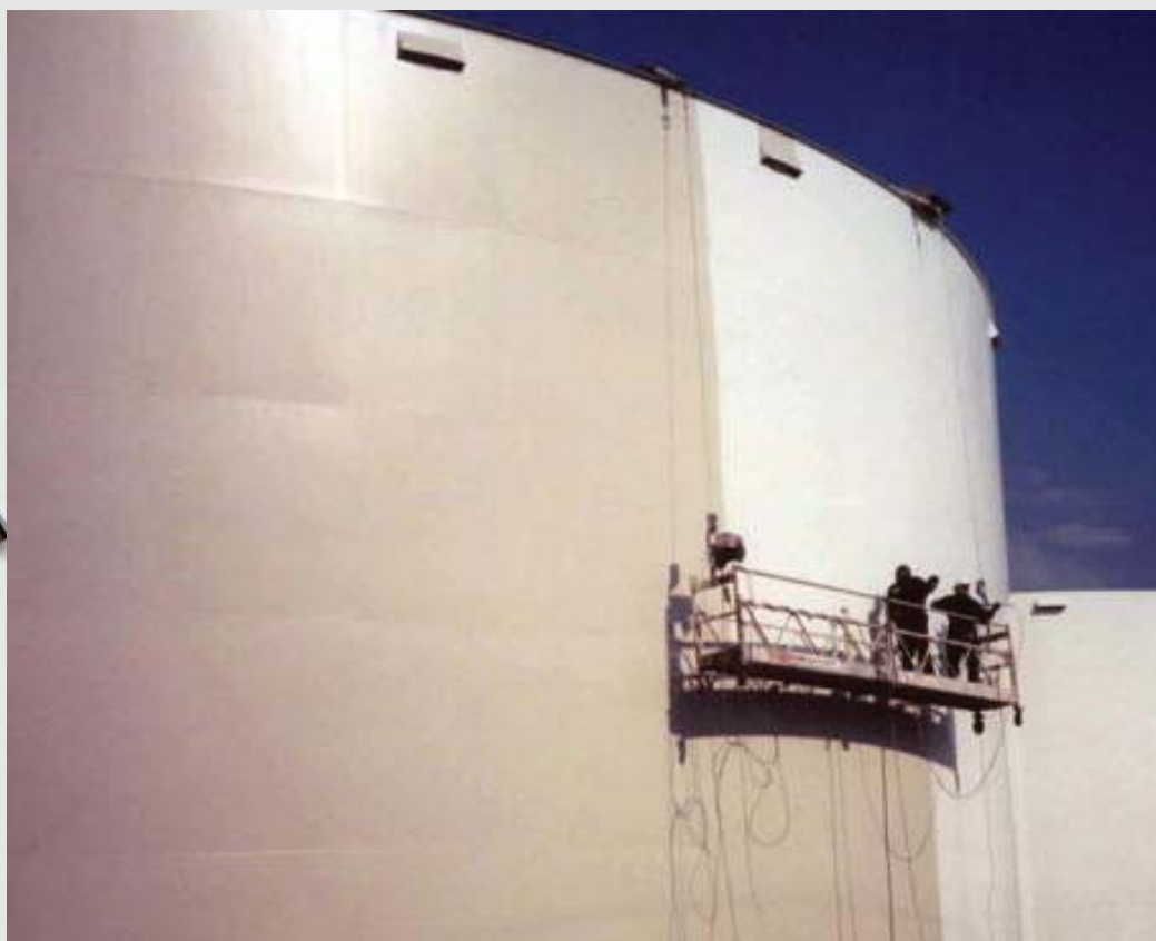
Tratamento de regiões localizadas, com presença de sais solúveis e corrosão, seguido da aplicação de revestimento epóxico e acabamento protetor branco em poliuretano. O máximo de proteção na recuperação de tanques industriais.
