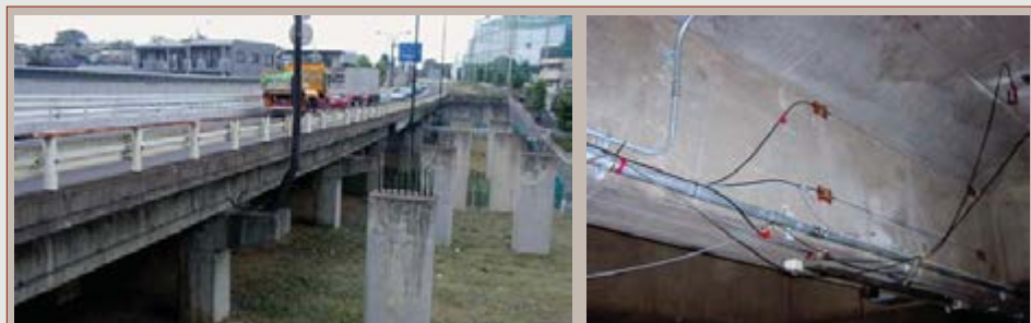
Viaduto construído na década de 70, com evidências (sinais) de fadiga, devido ao aumento incessante do tráfego. Sensores (cabos ópticos) posicionados tanto na zona de tração quanto na de compressão de uma viga longitudinal determina e monitora seu eixo neutro, fundamental para a análise.
