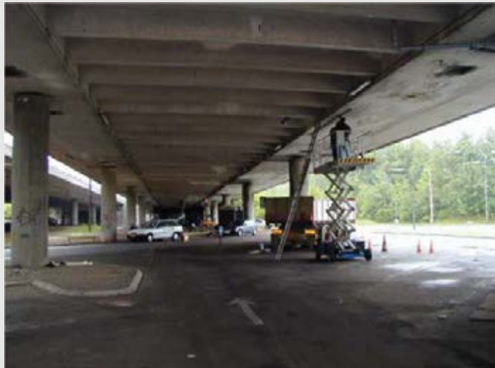
Sensor de deformação por flexão, com 5m, sendo instalado no meio do vão de uma viga caixão de viaduto...
