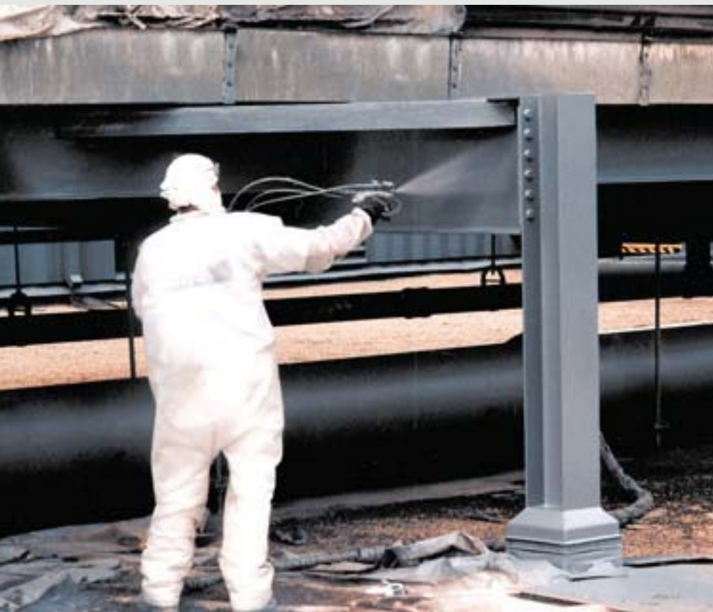
Pintura de proteção estervinílica em um pipe-rack industrial.
