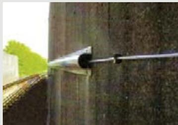
Instalação de cabo ótico com 10m de comprimento ao longo da seção curva do viaduto.
