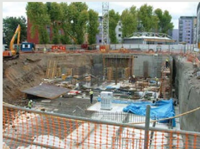
Escavação para obtenção da cota de fundação.
