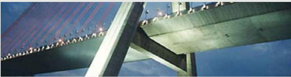
Na viga-caixão desta ponte, as deformações por fluência e retração têm significativa influência em seu sistema estrutural, particularmente em suas partes metálicas
