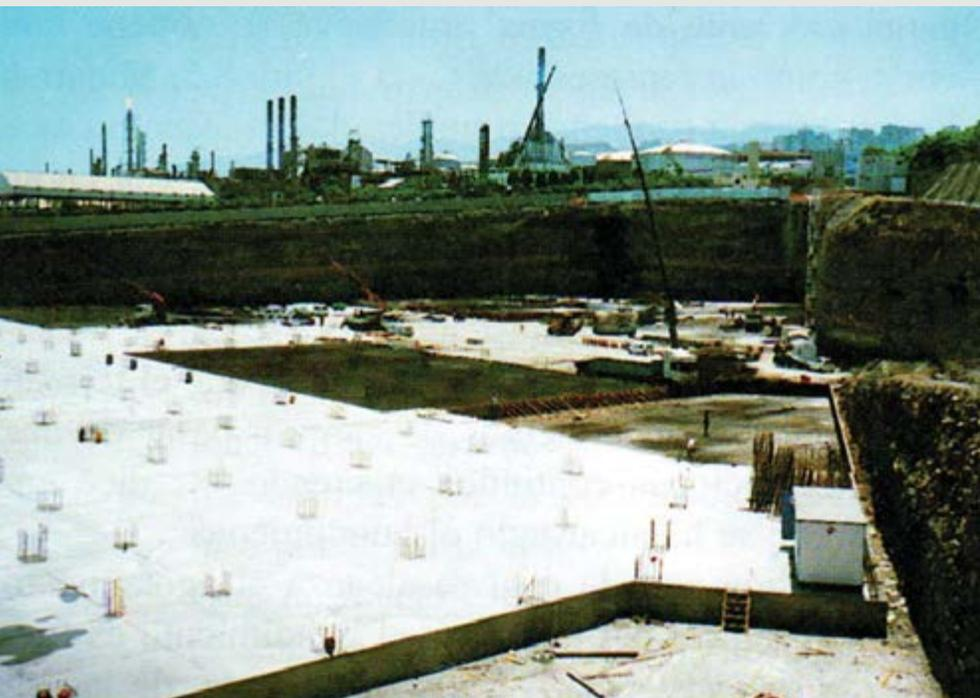
Execução de um grande radier para a construção de um centro comercial.
