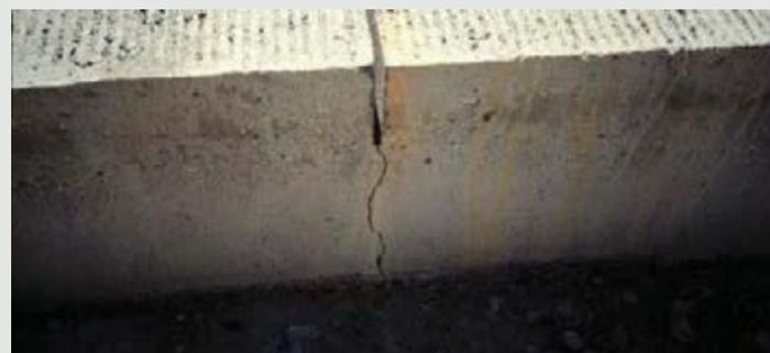
Trincas induzidas pelo corte da junta de controle.
