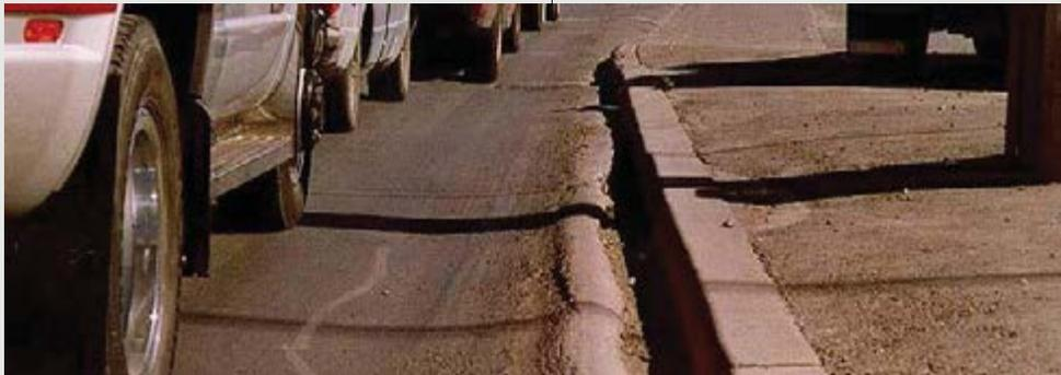
Típica degradação do pavimento asfáltico, devido a falta de condições para tal: ideal para overlay de concreto.
