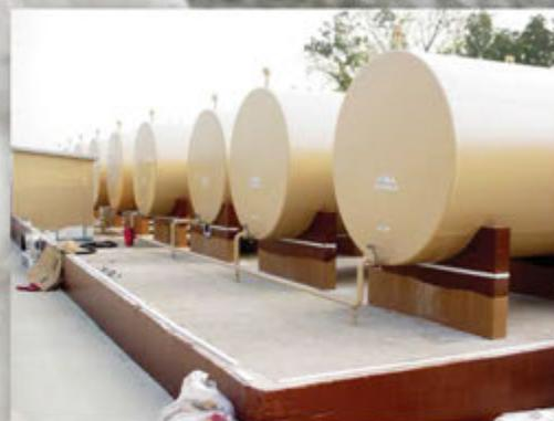
O **Piso-Dur NO CORR** é um revestimento cimentício (cimentos especiais) moderníssimo que atende à norma NBR-17505-2 para proteção secundária em bacias de tanques industriais que estocam óleos orgânicos/inorgânicos ou corrosivos.
