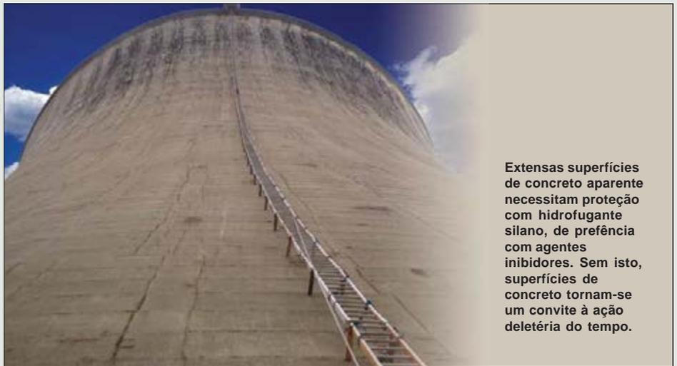
Extensas superfícies de concreto aparente necessitam proteção com hidrofugante silano, de preferência com agentes inibidores. Sem isto, superfícies de concreto tornam-se um convite à ação deletéria do tempo.
