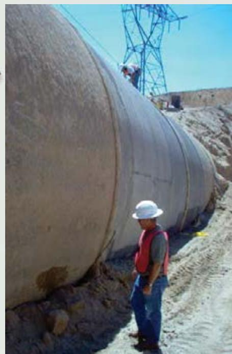
Tubulações de concreto são campeãs em matéria de patologias por contaminação, devido a solos submetidos a águas sulfatadas.
