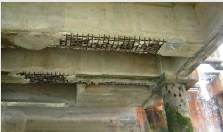
Estruturas de portos são as que mais sofrem pela inobservância do quesito durabilidade. O concreto e o aço não resistem ao meio marítimo. É preciso protegê-los adequadamente.
