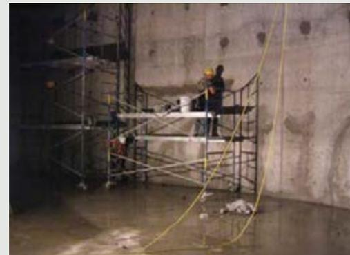
Esta parede de concreto, alguns meses após sua concretagem, ainda desenvolvia trincas de retração que, paulatinamente, foram tratadas.
