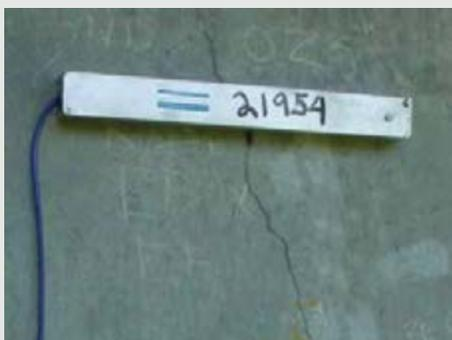
Sensor para monitorar movimento de uma trinca no tabuleiro do viaduto.
