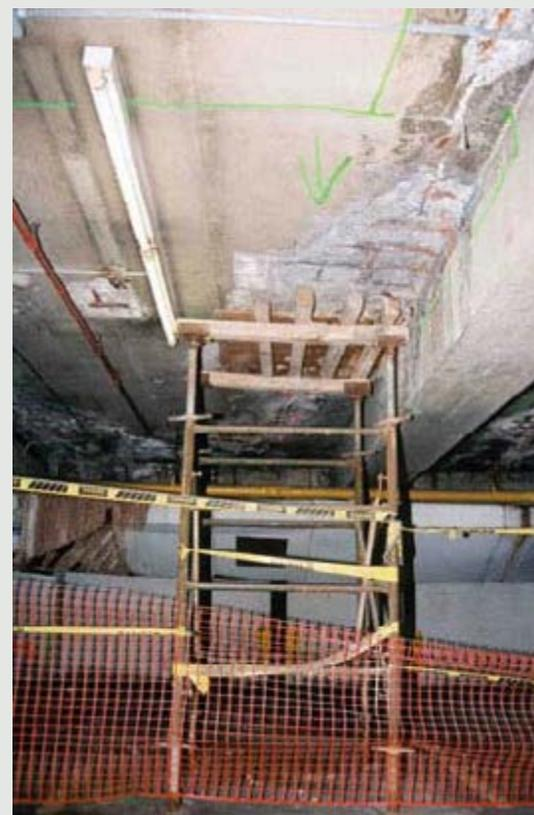
Fundo de laje em uma indústria química. A contaminação do concreto por produtos químicos desencadeia sua lenta destruição e a corrosão nas armaduras.
