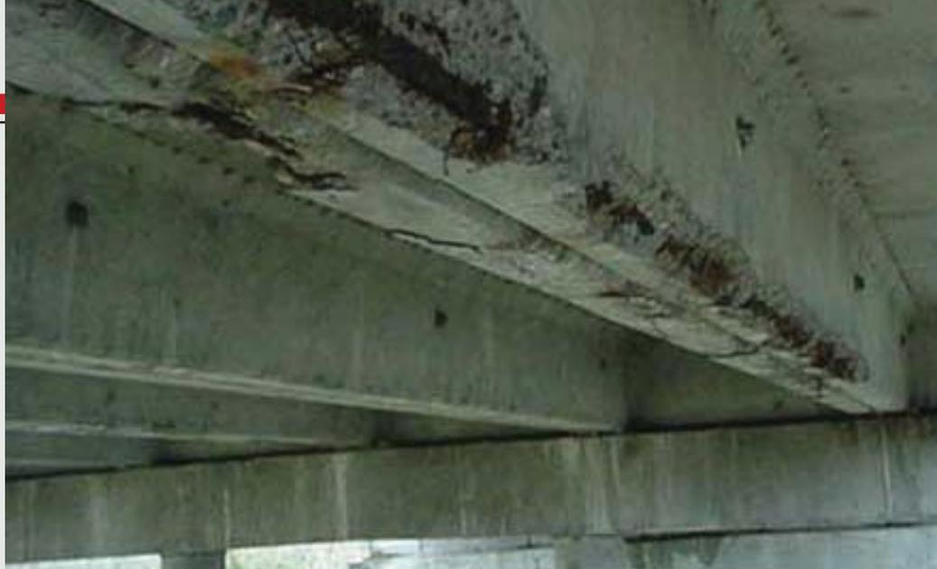
Sérios processos de corrosão nas vigas deste viaduto.
