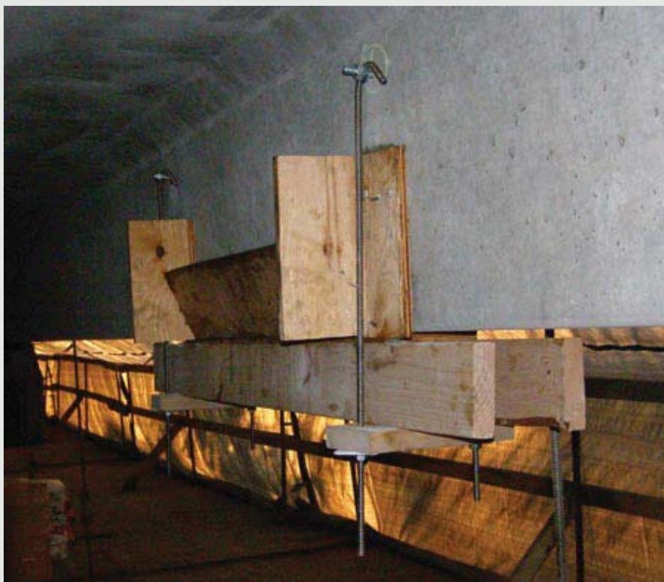
Técnica de recuperação estrutural com preenchimento, utilizando-se "cachimbo" neste fundo de viga.
