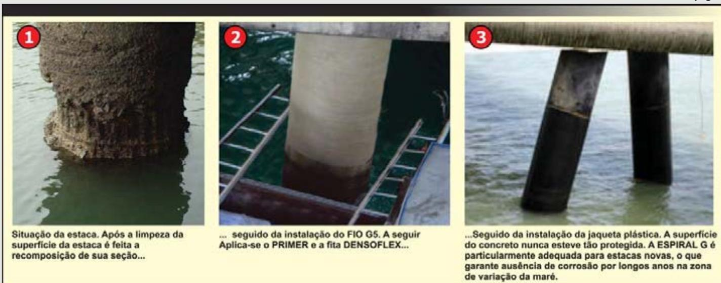
1 Situação da estaca. Após a limpeza da superfície da estaca é feita a recomposição de sua seção...
