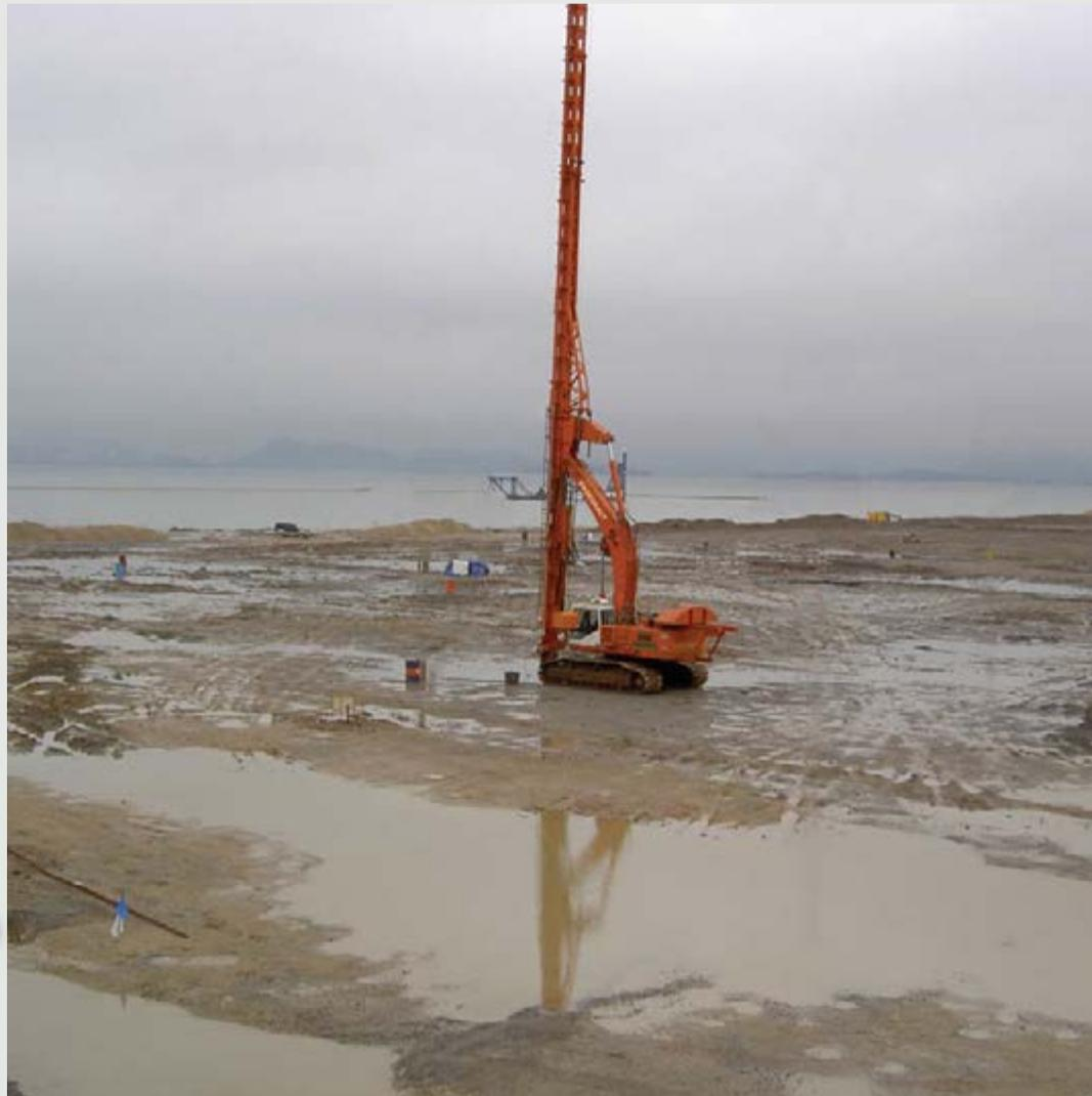
Processo de consolidação por CPR em andamento: cravação de geodrenos num local formado por camadas de solo argiloso marinho, altamente compressível, para posterior execução de bulbos e colunas de compactação que darão a consolidação desejada (CPR). O processo é acompanhado por piezômetros e curvas pressiométricas.
