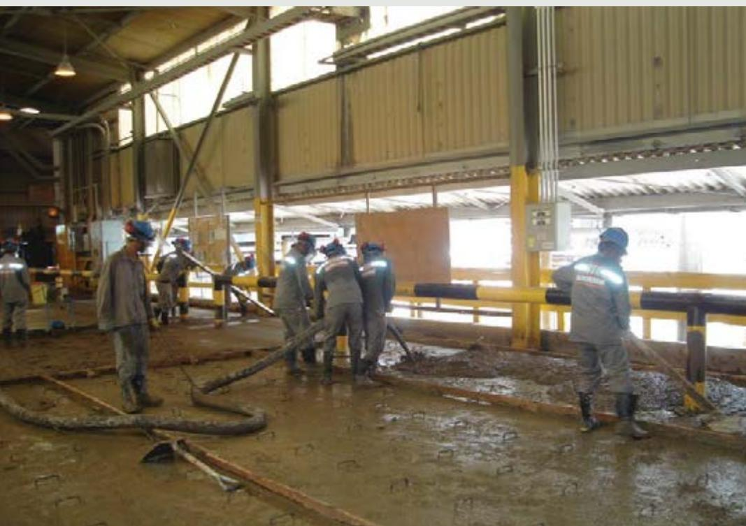
Detalhe preparatório para o lançamento de um overlay de concreto para um pavimento industrial.
