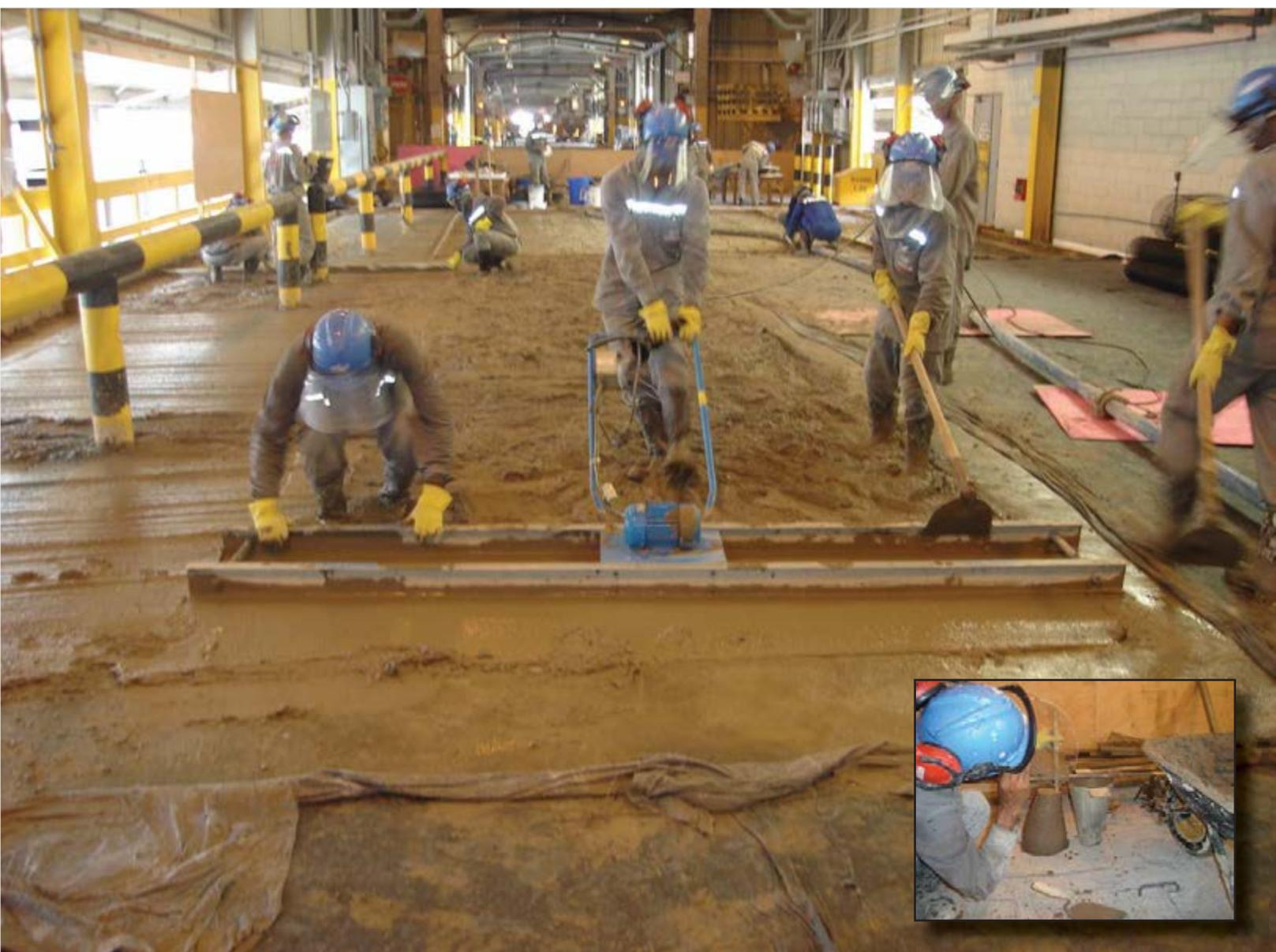
Execução de um overlay de concreto para melhorar a condição do antigo pavimento.
