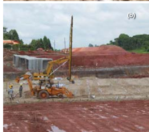
CPR no Rodoanel, em São Paulo: cravação de tubos (a) e drenos verticais (b) em uma área de 4.250m 2 às margens da represa Billings.
