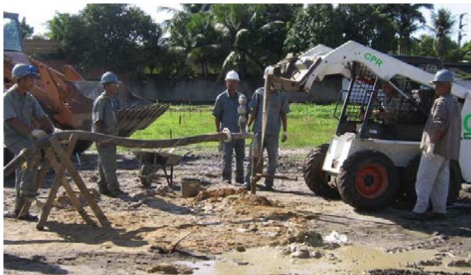
Mangueira, manômetro, tubo de bombeamento e geodrenos. O CPR em ação em um terreno com solo mole de 30.000 m 2 , em Recife.
