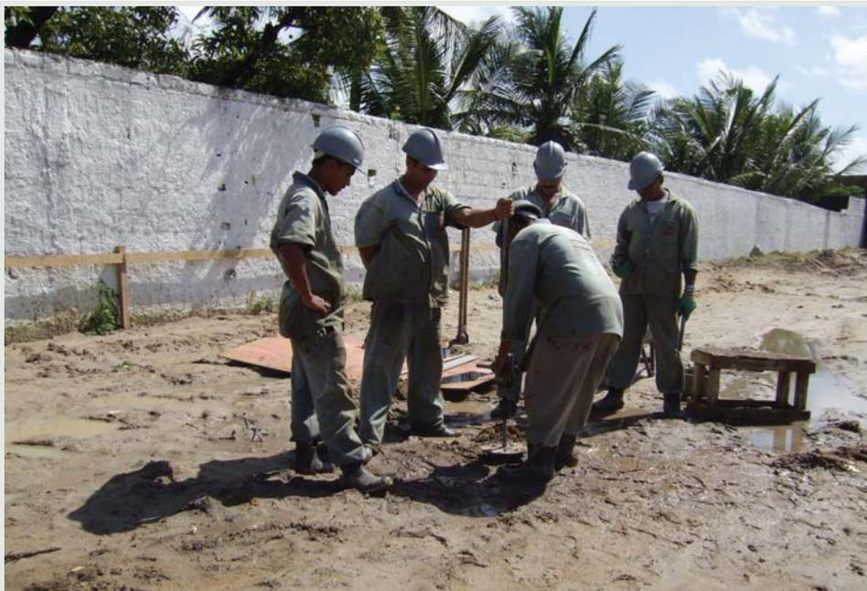
Terreno com 8m de solo mole sendo sondado com CPT dinâmico, de modo a se obter a resistência ao cisalhamento não drenado antes dos serviços de CPR.
