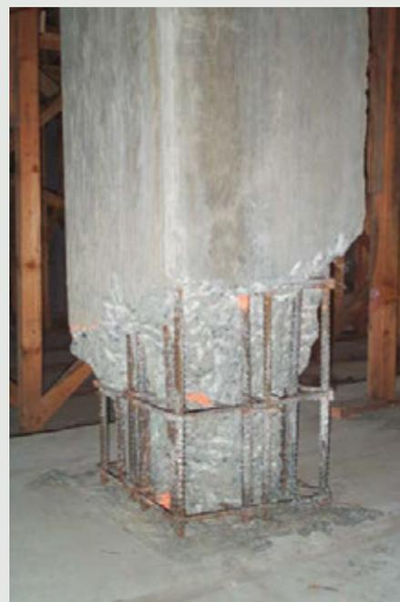
Figura 3 - Peças de concreto armado que se submeterão a serviços de recuperação e tratamento da corrosão. As argamassas de recuperação farão o trabalho final.
