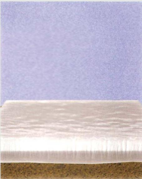
Figura 2 – A cura úmida promove a melhor oportunidade para o concreto obter sua completa resistência, inclusive à abrasão.
