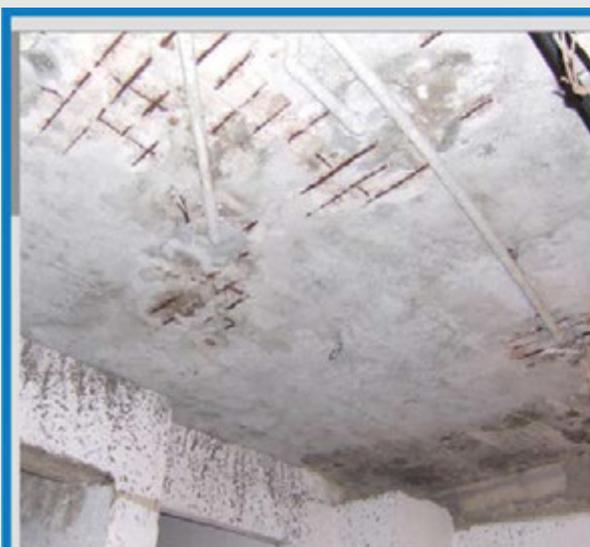
Situação comum: ausência da camada de recobrimento e corrosão nas armaduras da laje. Solução: proceder o corte do concreto junto às armaduras e justapor, lateralmente, o FIO G\* amarrando-o a cada 10cm com arame comum. Laje protegida por muitos anos.
