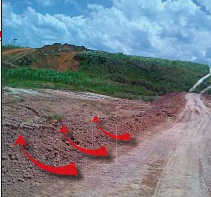
A colocação de aterros sobre solos moles provoca, de imediato, a formação do recalque imediato (apresentado na edição anterior). Repare o levantamento do solo à esquerda da foto.
