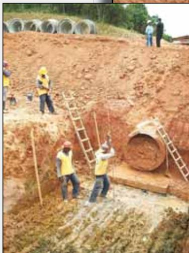
O CPR sendo analisado com sondagem CPT (Piezocone) numa obra em Salvador. Na foto menor um teste rápido, após a escavação do solo consolidado, testando-o através de penetração com barra. Este solo era o fundo de um lago. Repare que já não existe mais água no solo.
