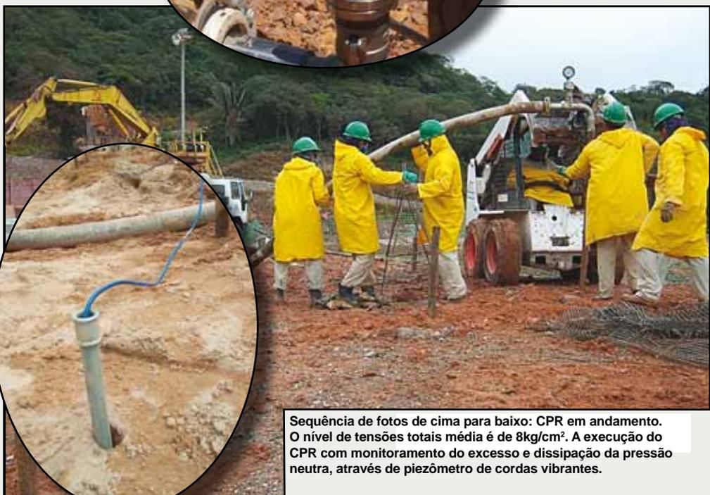
Sequência de fotos de cima para baixo: CPR em andamento. O nível de tensões totais média é de 8kg/cm². A execução do CPR com monitoramento do excesso e dissipação da pressão neutra, através de piezômetro de cordas vibrantes.
